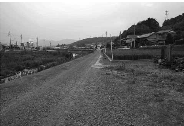
二番堰用水旧取水堰跡(東から)
