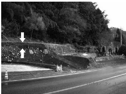
写真18 小野子の天明泥流堆積物断面 写真の矢印間に天明泥流堆積物が分布している。
