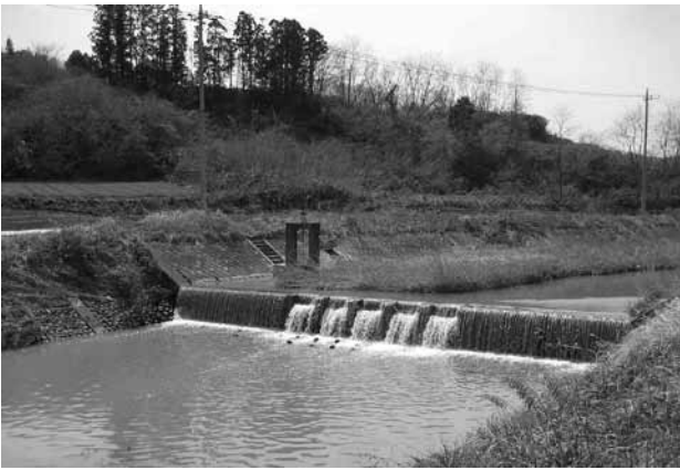
甘楽用水現山下堰(北東から)
