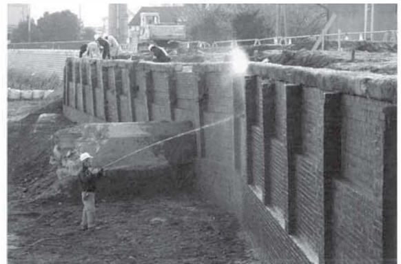
煉瓦護岸表面被覆土除去作業(西から)
