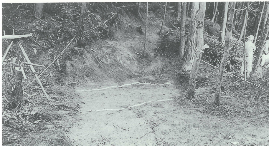
A区通路03 検出状況
