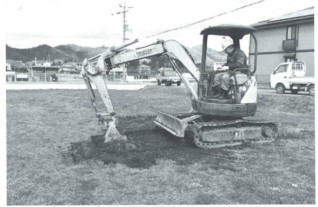
埋め戻し状況
