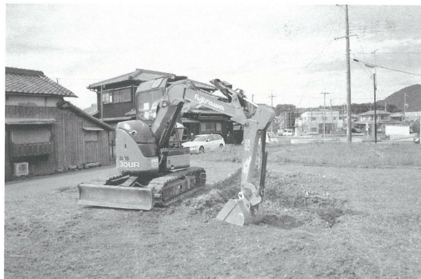
埋め戻し状況
