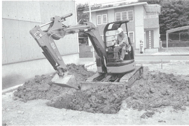
埋め戻し状況
