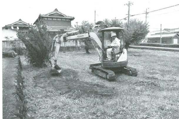
埋め戻し状況
