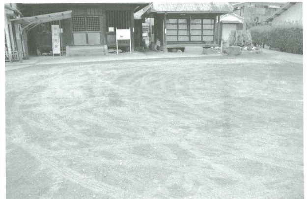
埋め戻し後状況
