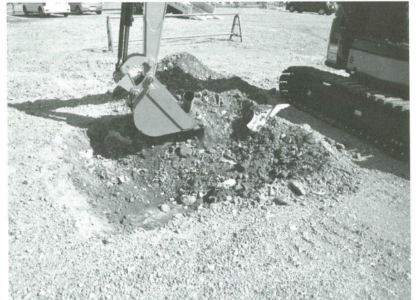
G19機械掘削
