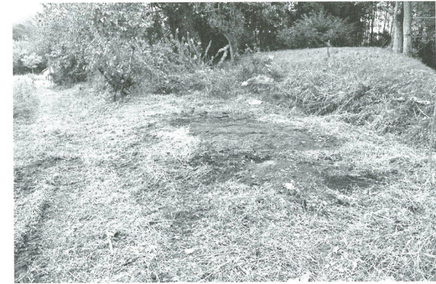
埋め戻し後状況
