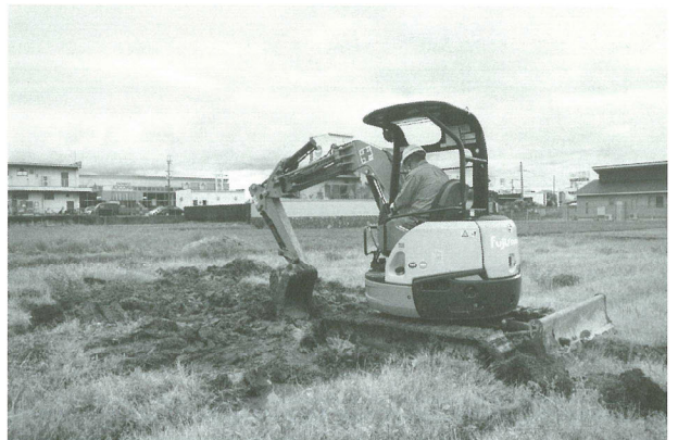
埋め戻し状況
