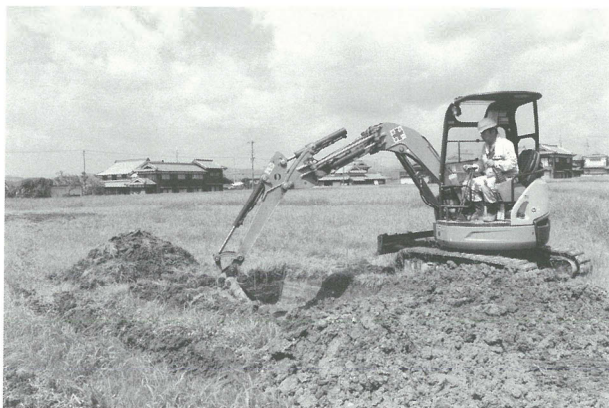
埋め戻し状況
