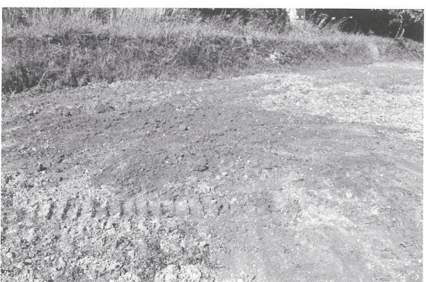
埋め戻し後状況
