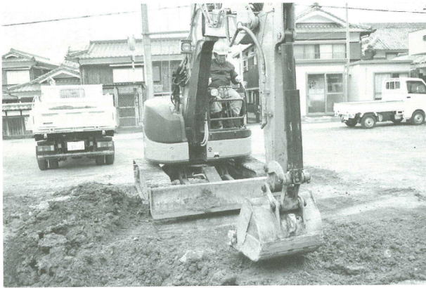
T1埋め戻し状況
