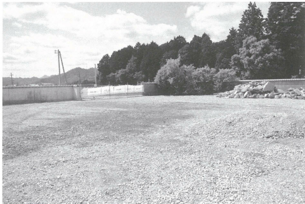
埋め戻し後状況
