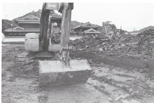
下層機械掘削
