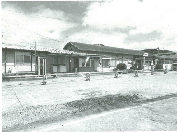
埋め戻し後状況
