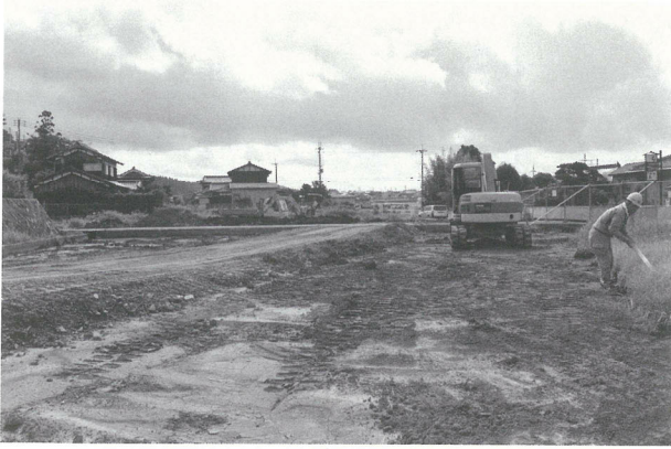
調査地点全景（西から）
