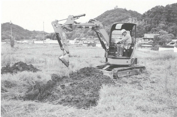
埋め戻し状況
