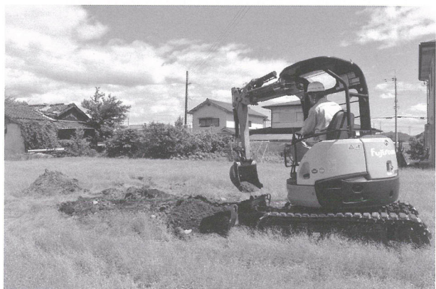
埋め戻し状況
