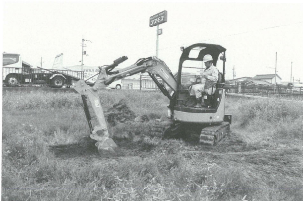
埋め戻し状況
