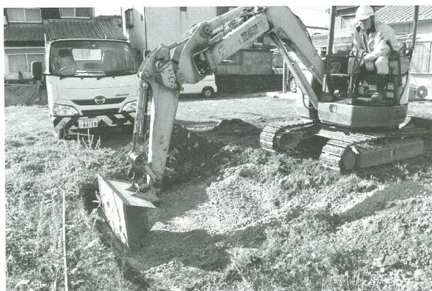
G1掘削状況
