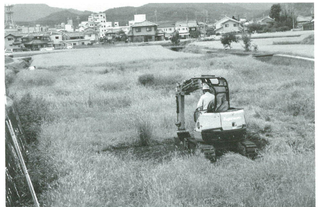
埋め戻し状況
