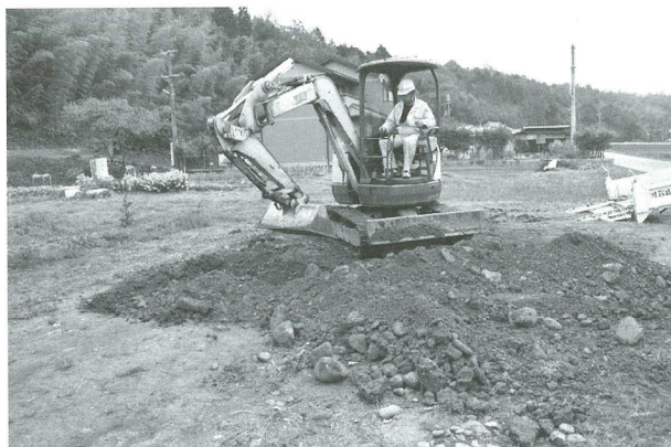
埋め戻し状況
