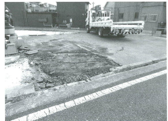
坪19 埋め戻し後の状況
