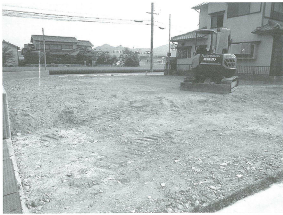
調査前の状況
