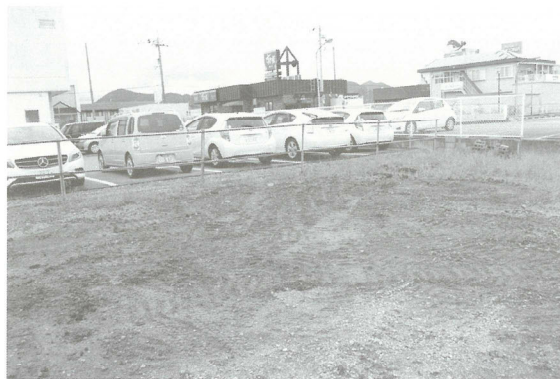
埋め戻し後の状況
