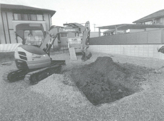
埋め戻し作業
