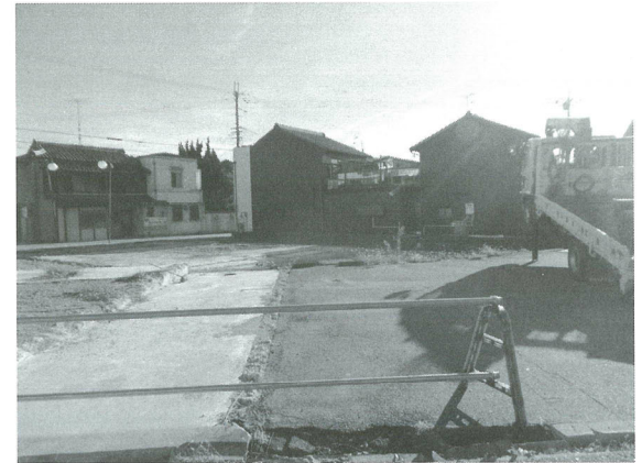
坪19 調査前の状況（南から）
