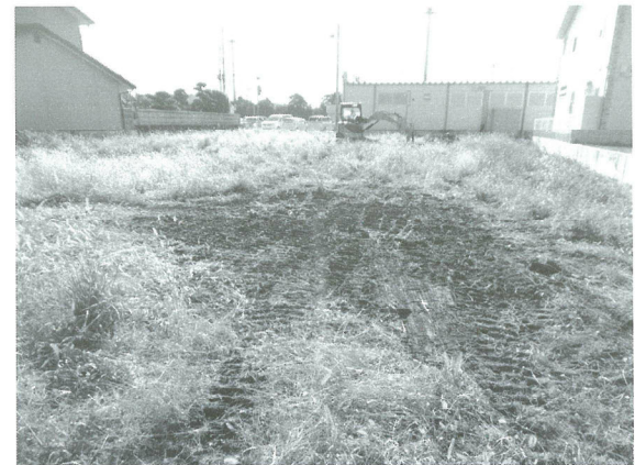
埋め戻し後の状況
