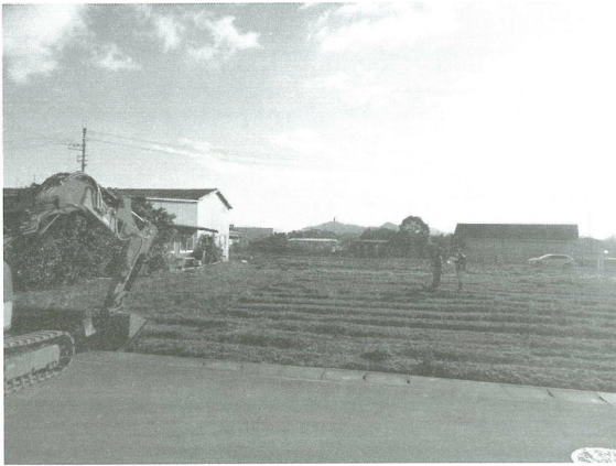
調査前の状況 (西から)
