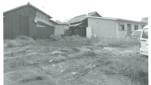
坪11 埋め戻し後の状況
