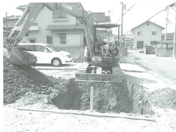
埋め戻し状況
