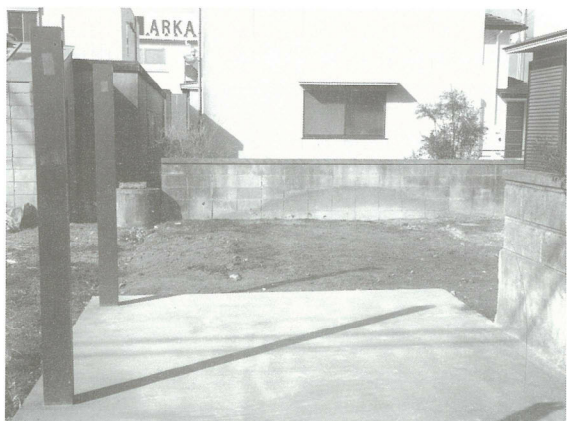
埋め戻し後状況
