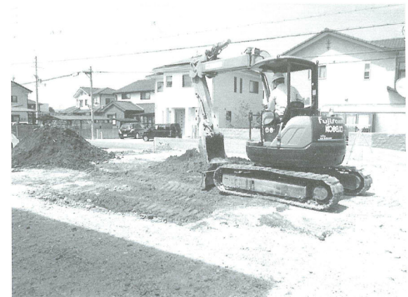
埋め戻し状況
