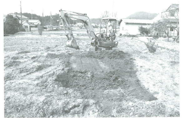
埋め戻し作業
