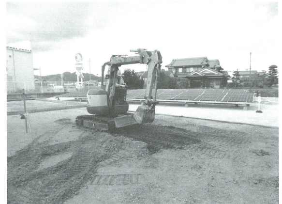
埋め戻し作業
