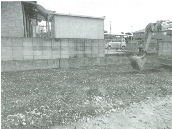
調査前の状況 (西から)
