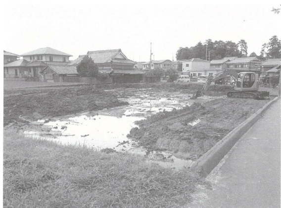
埋め戻し後の状況
