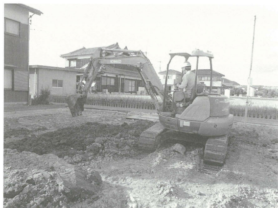
埋め戻し作業
