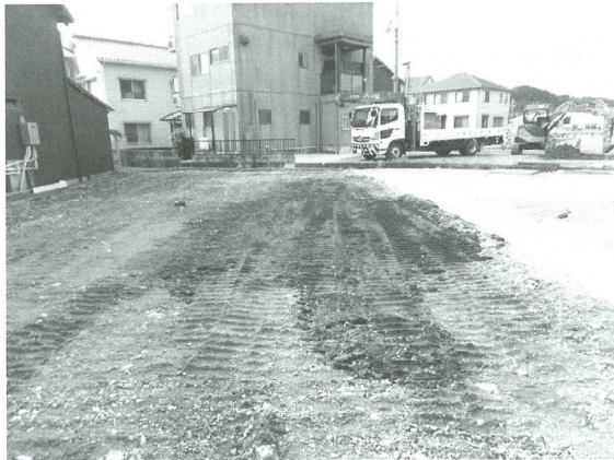
坪18 埋め戻し後の状況
