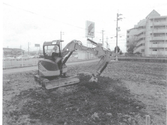
埋め戻し作業
