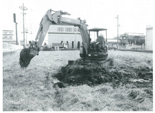
埋め戻し作業
