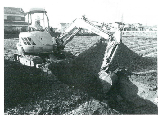
埋め戻し作業
