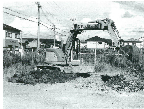
埋め戻し作業
