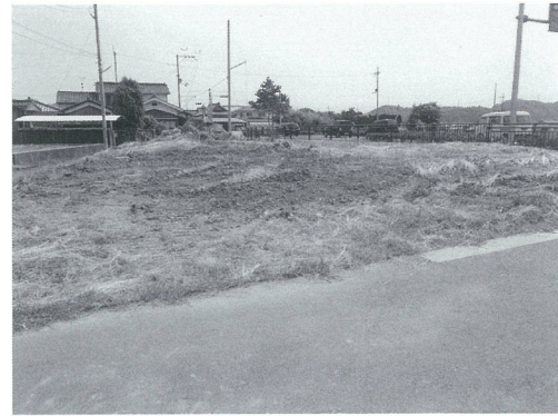
埋め戻し後の状況
