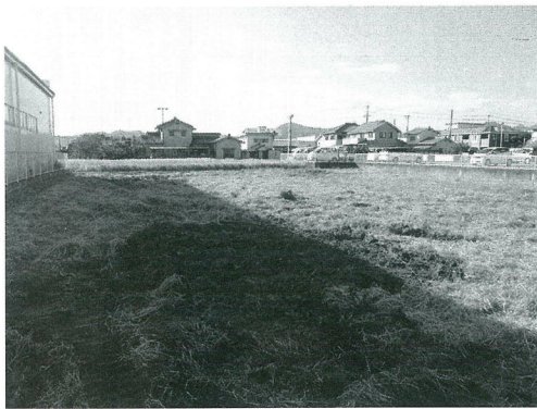
埋め戻し後の状況
