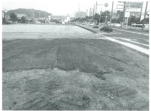
埋め戻し後の状況
