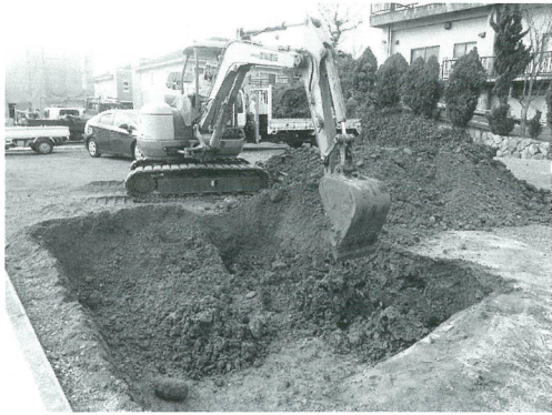
埋め戻し作業
