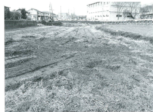
埋め戻し後の状況
