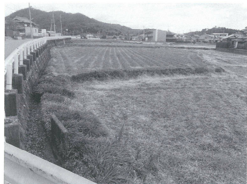
調査前の状況
