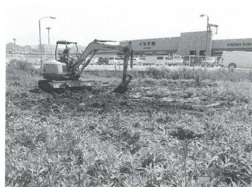
埋め戻し作業
