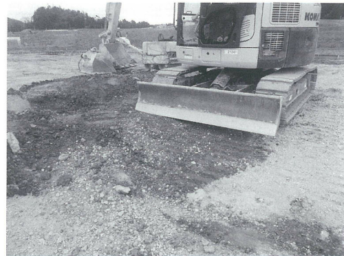
埋め戻し作業
