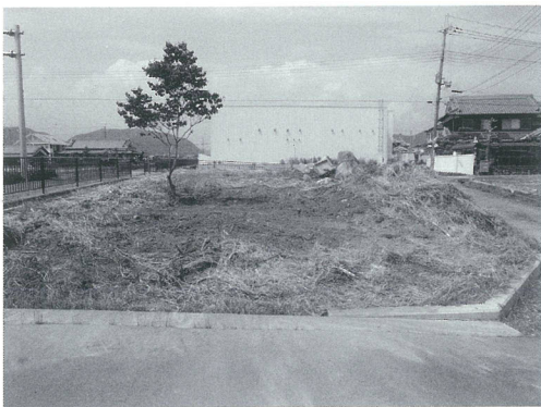
埋め戻し後の状況
