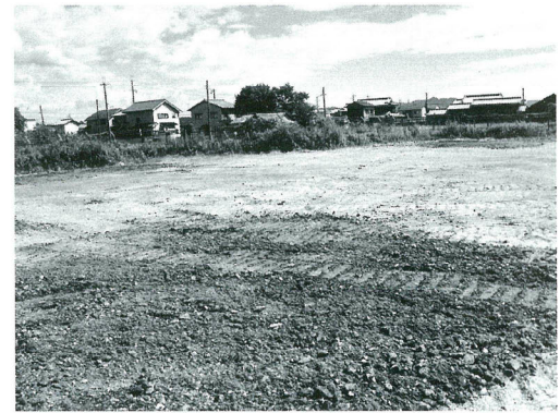
埋め戻し後の状況
