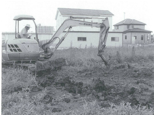
埋め戻し作業
