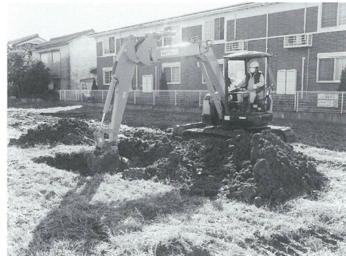
埋め戻し作業
