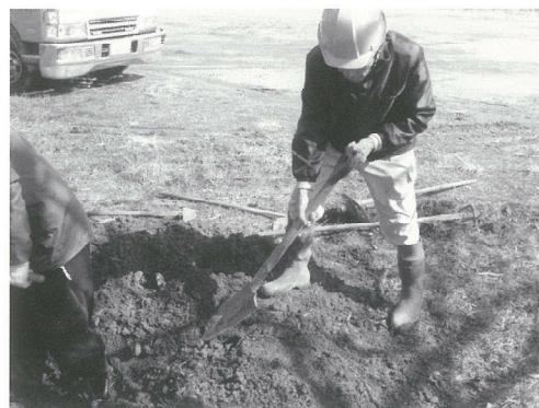
トレンチ2埋め戻し作業
