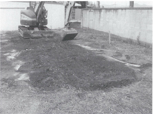
重機埋め戻し作業
