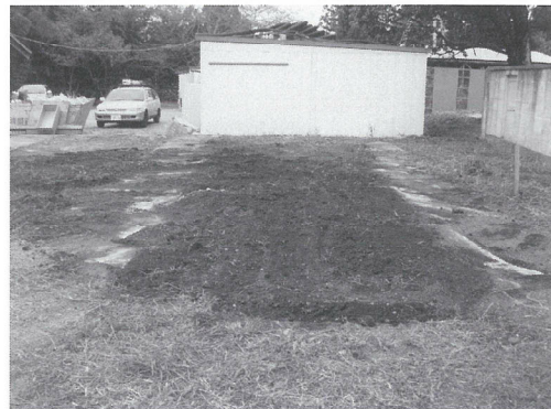
埋め戻し完了
