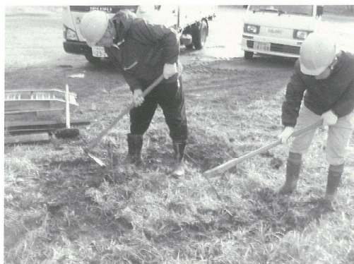
手掘り掘削作業
