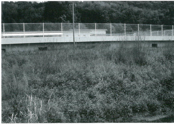
調査前の状況
