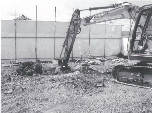
調査区1 掘削状況
