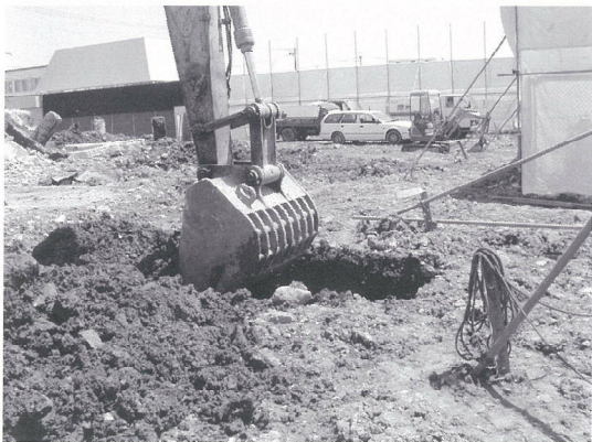
調査区2 掘削状況
