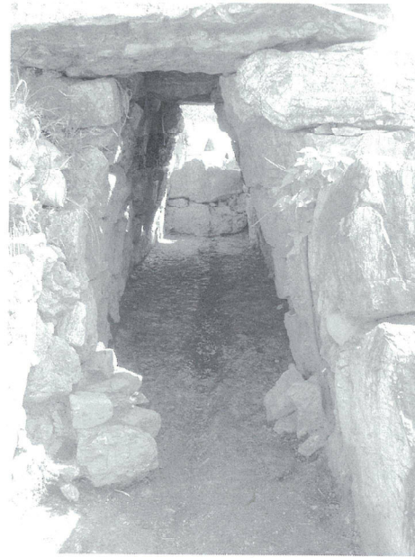
排水溝検出状況（西から）
