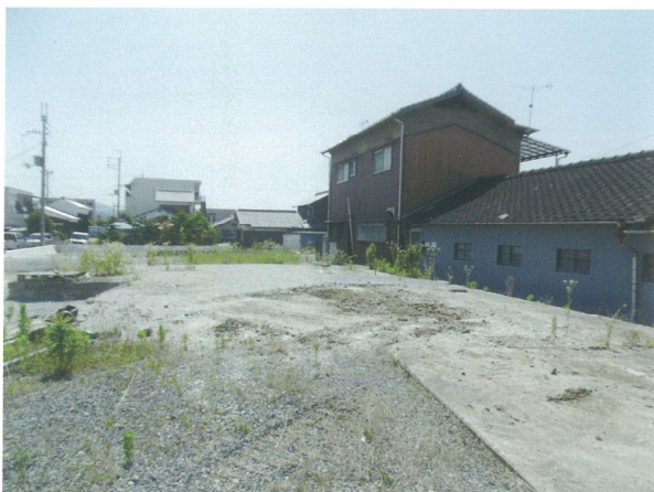
6G 埋め戻し終了 (南から)
