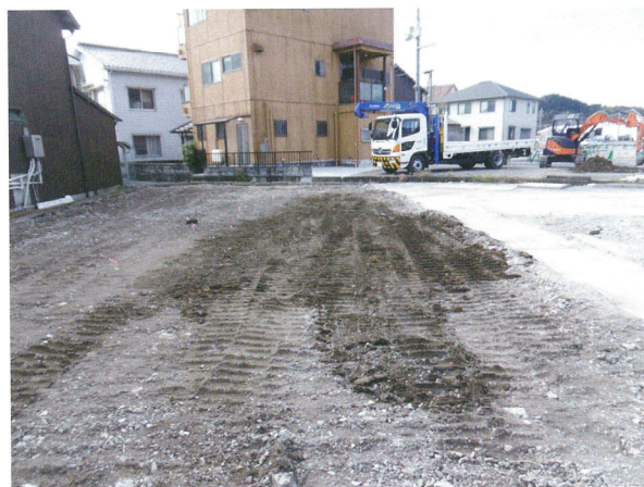
18G 埋め戻し終了(北から)
