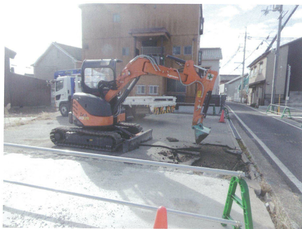
19G 機械掘削
