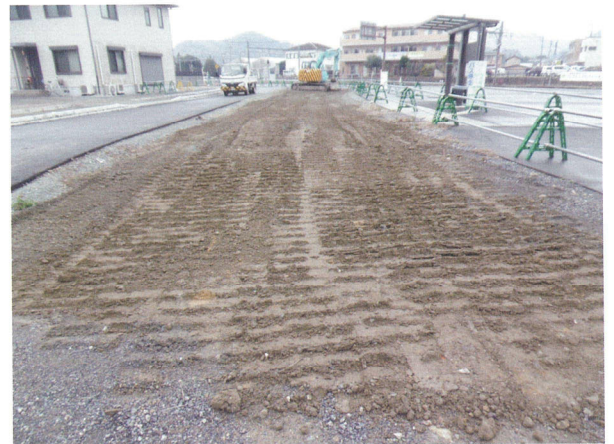
埋め戻し終了後（北から）
