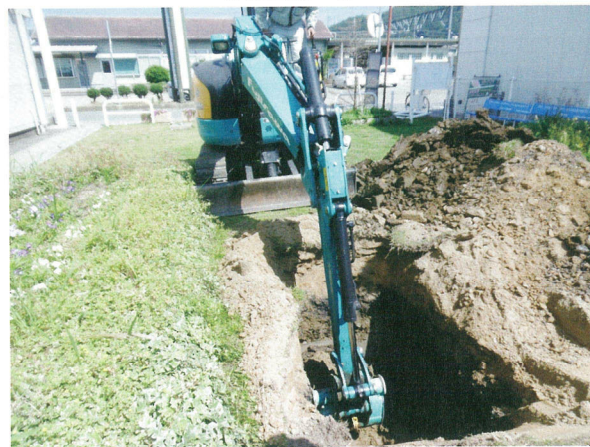
17-1G 機械掘削
