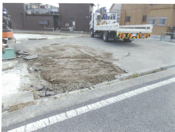
19G 埋め戻し終了 (南東から)
