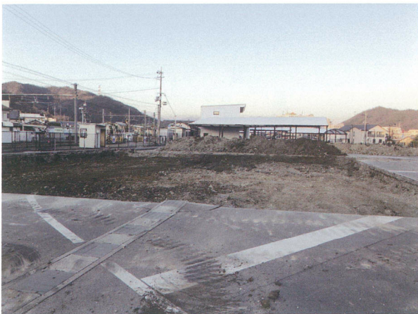
調査前（改良土除去後・南から）
