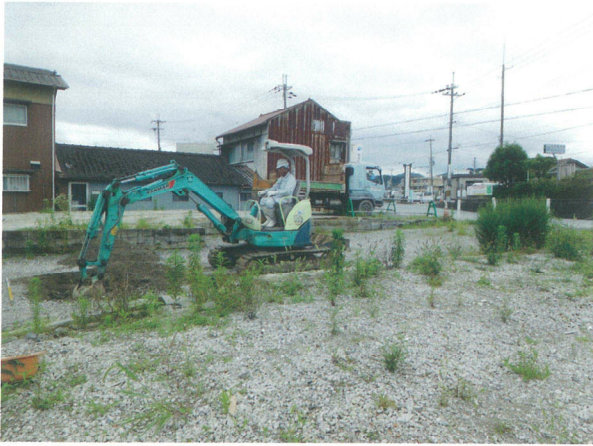
1G 機械掘削
