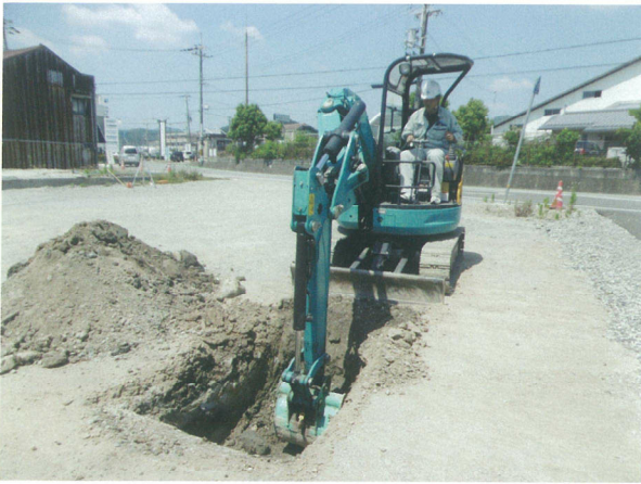
5G 機械掘削
