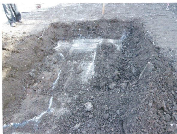
18G コンクリート基礎検出状況
