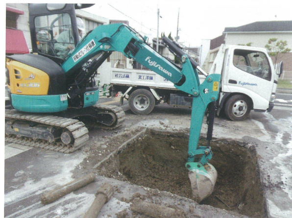
15G 機械掘削
