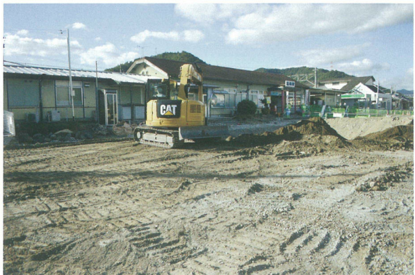
調査区西側埋め戻し状況
