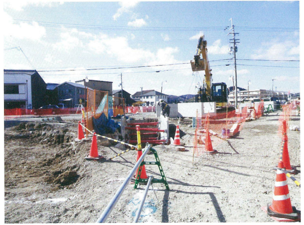
駅前東側（工事立会）
