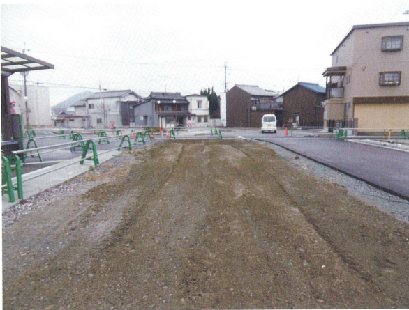
埋め戻し終了後（南から）
