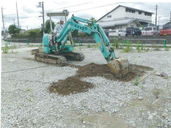
2G 機械掘削
