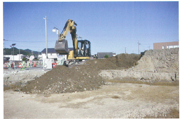
調査区東側埋め戻し状況
