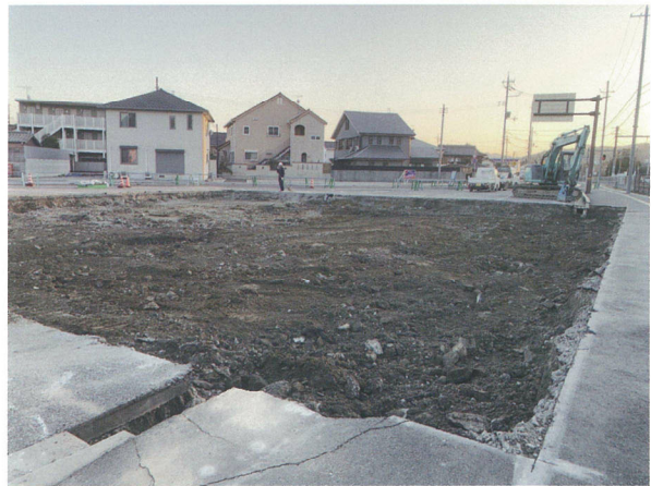
調査前（改良土除去後・南西から）
