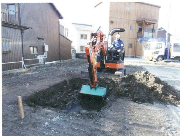
18G 機械掘削
