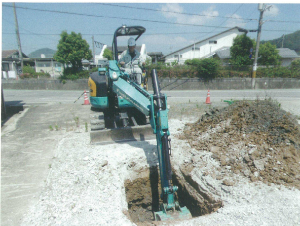
6G 機械掘削
