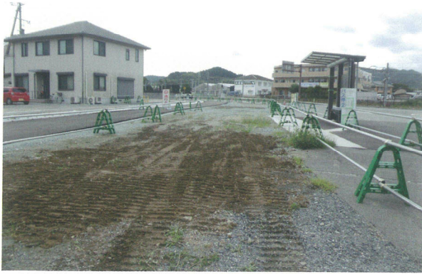
13G 埋め戻し終了 (北から)
