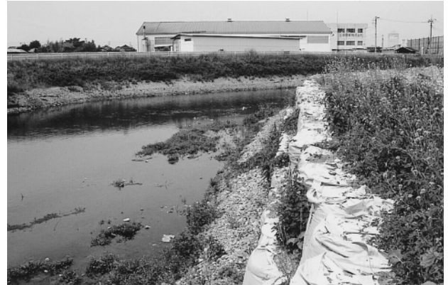
写真1 井野川左岸の段丘礫層 (綿貫地点)
