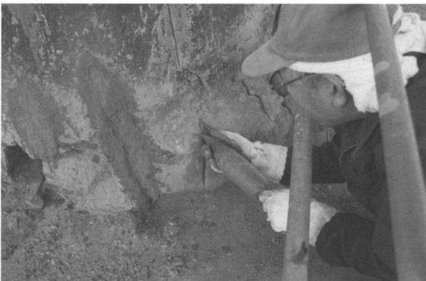
写真34 炉体の補修
