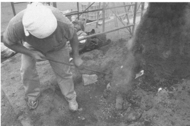
写真22 9:40 湯口（排滓孔）を突く
