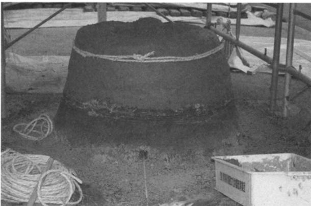
写真13 荒縄を巻き付けて補強
