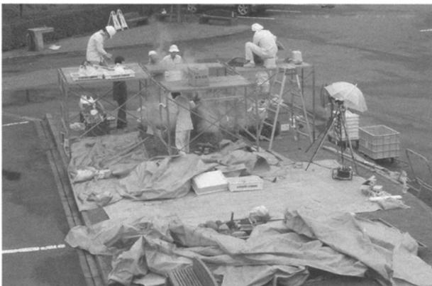
写真21 9:20 マツ炭1.0kg投入、砂鉄0.7kg投入
