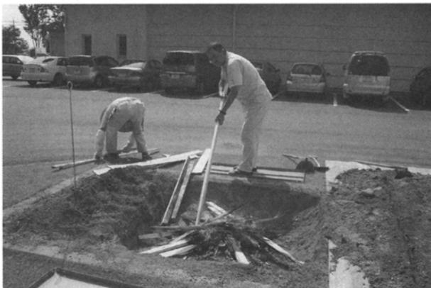
写真8 炉の下部構造の乾燥
