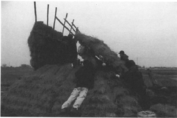
② 棟部分の組み立て
