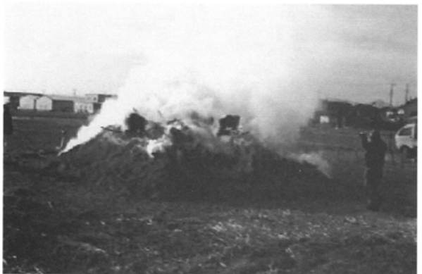
⑧ 崩落の途中（棟の崩落段階）
