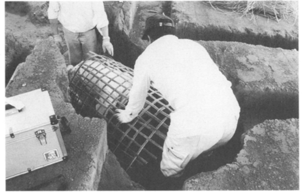
図6 天井骨組設置作業（2号実験窯）
