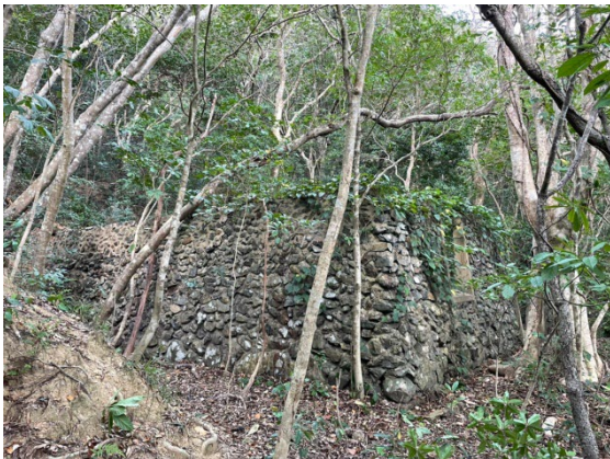
土塁跡・弾薬庫跡（ドック周辺）
