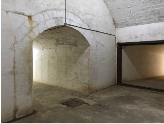
第2弾薬庫跡通路（コンクリートブロック巻き）
