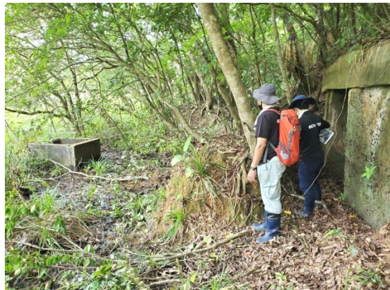
第1防空壕跡・コンクリート柵
