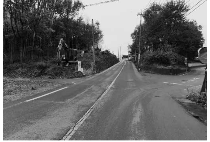
2. 調査区遠景(東から)
