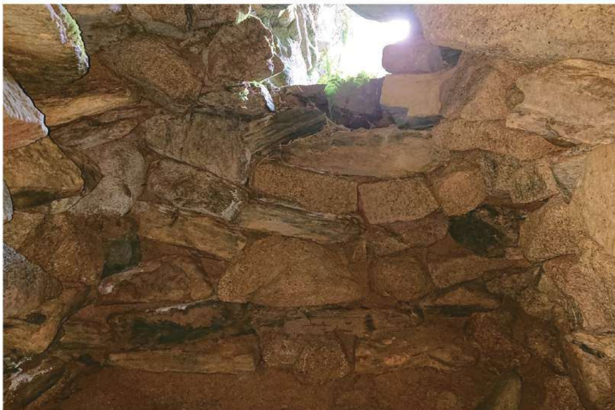
1. 西壁正面観 [平成16年撮影]
