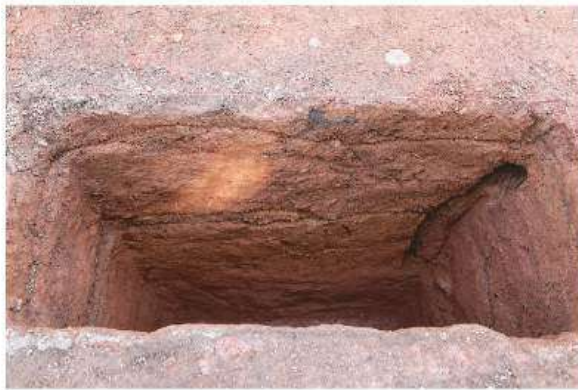
3.9 トレンチ南東調査区東壁 (西より)
