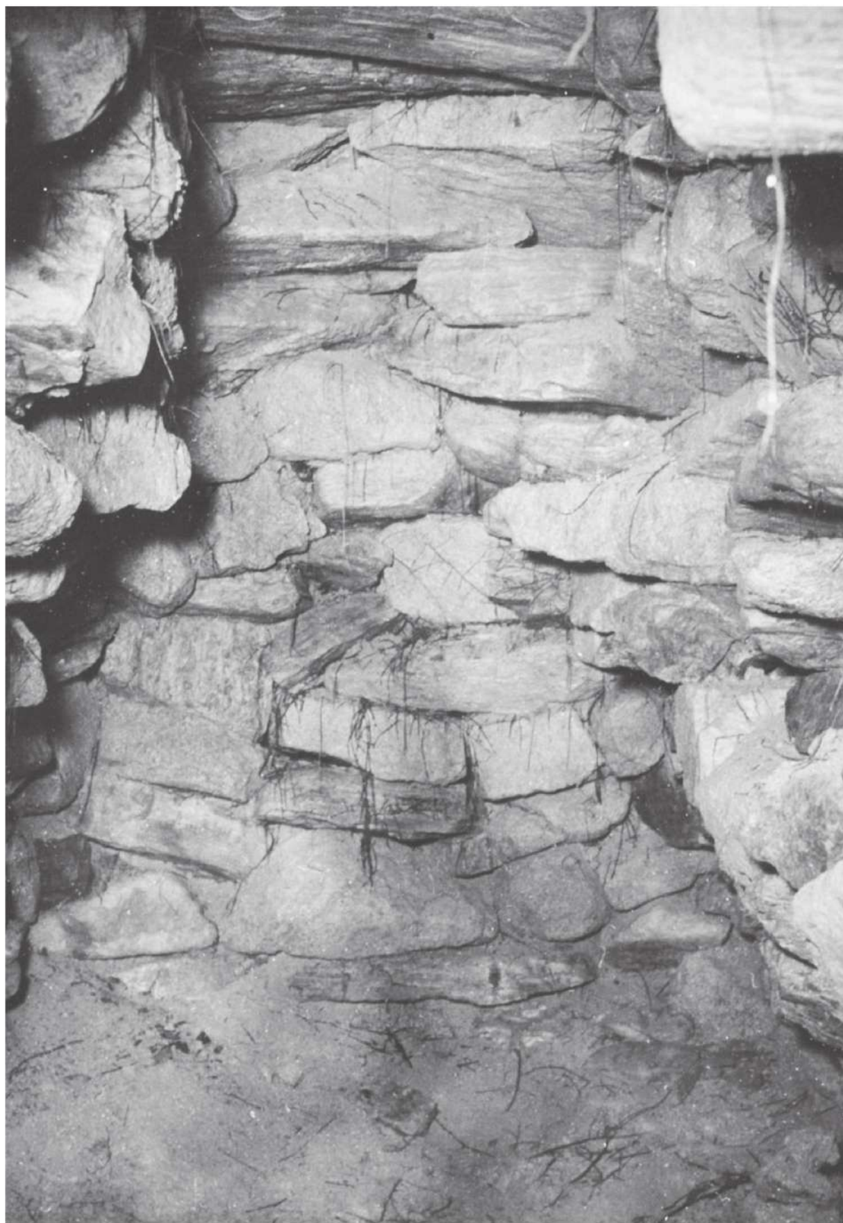
西壁〔第1次調査〕
