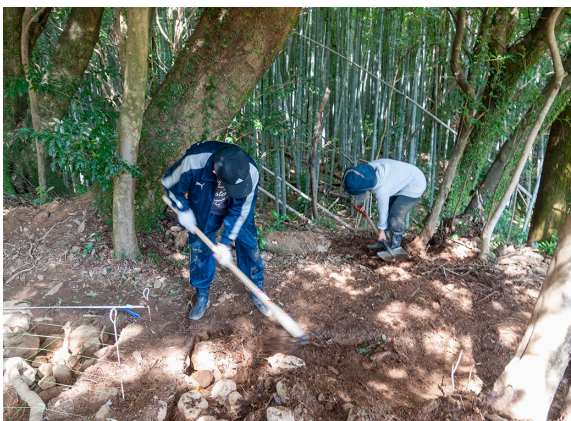
写真68 埋め戻し作業(T5、南から)
