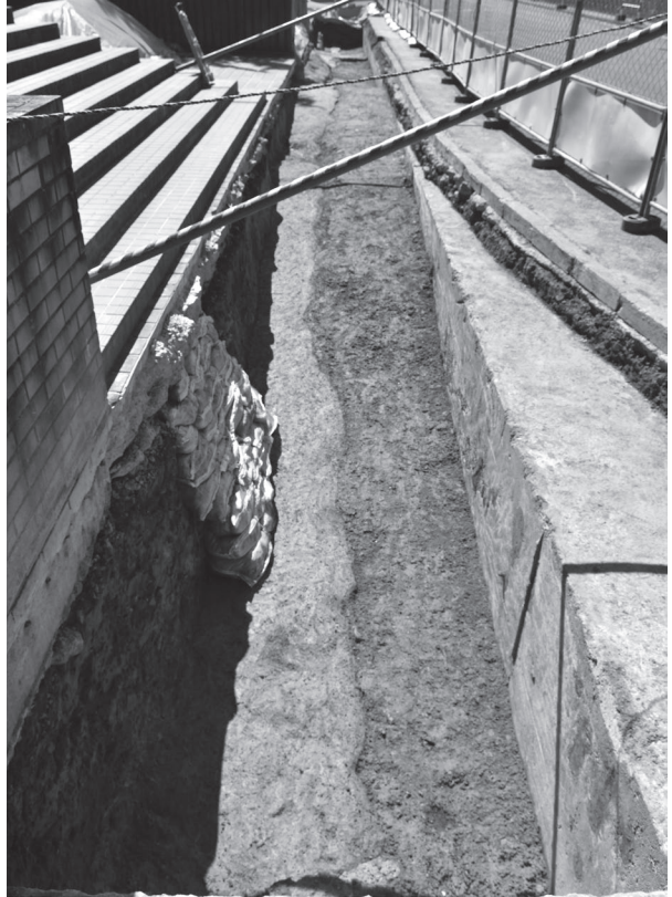
2. B区調査終了状況（東から）
