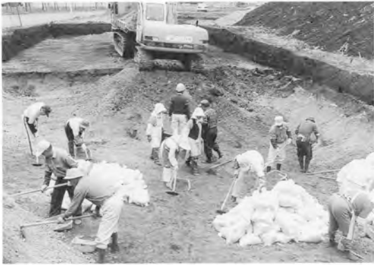
A区F P除去作業
