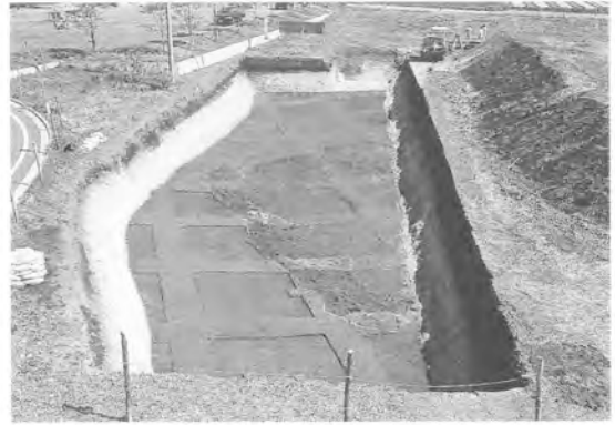
A区F P 混土除去面 (南から)
