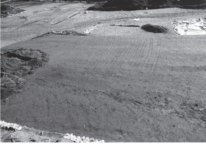
1 第4面畑第7区画遺構確認状況 北から
