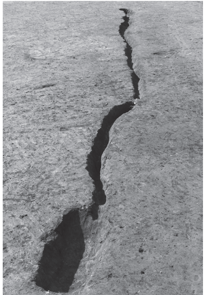
4 16号溝 北から 手前は復旧溝67
