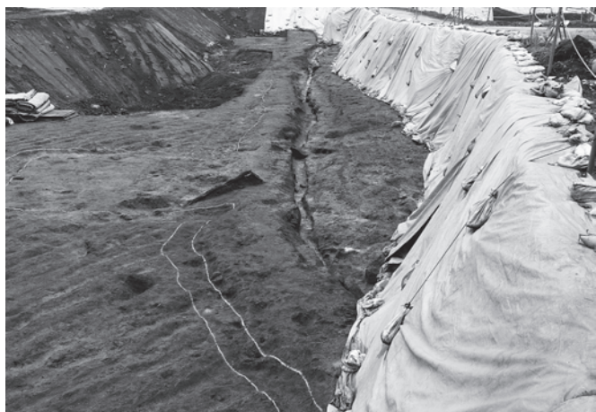
4 同 西部・2号建物 西から
