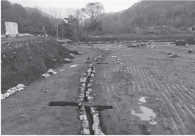
1 2号水路中部 西から
