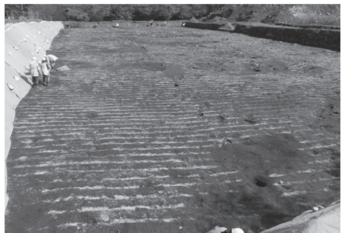
5 同部分 南から
