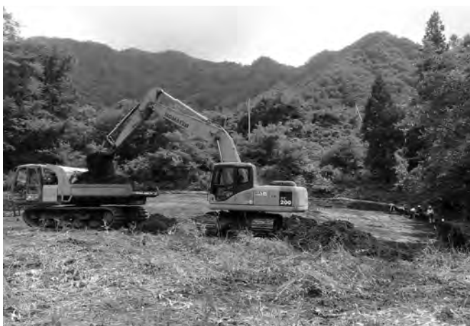
8. 表土掘削(北から)
