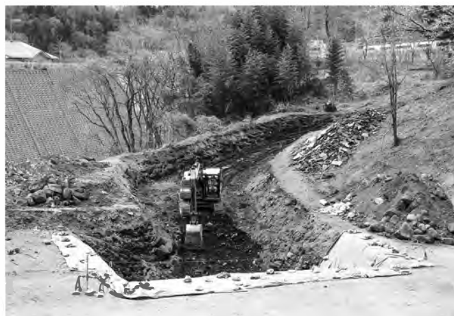
6. D区南部表土掘削風景(東から)
