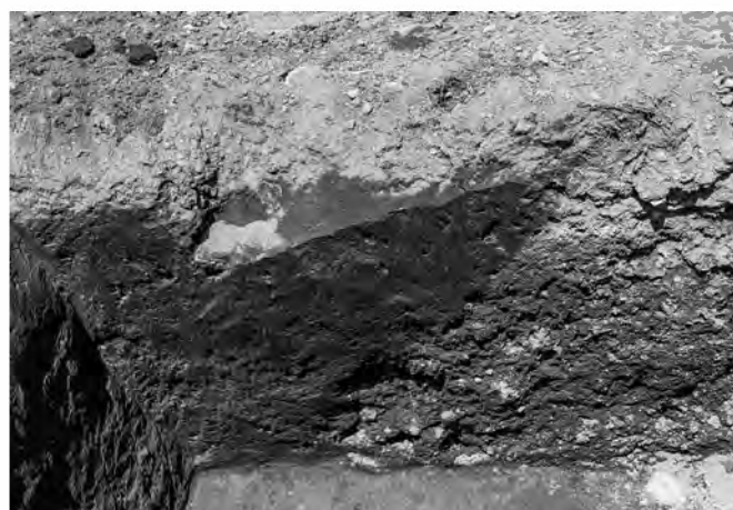
9. D区3号トレンチ(南東から)
