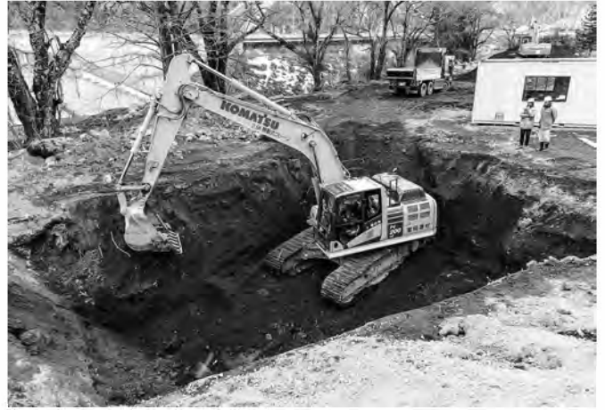
2. E区1面掘削作業風景(北から)
