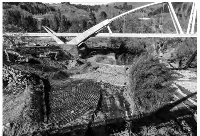
8. B区1面掘削作業風景(南から)
