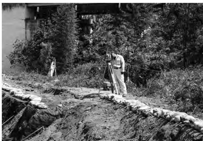
7. D区北西部測量作業風景(東から)
