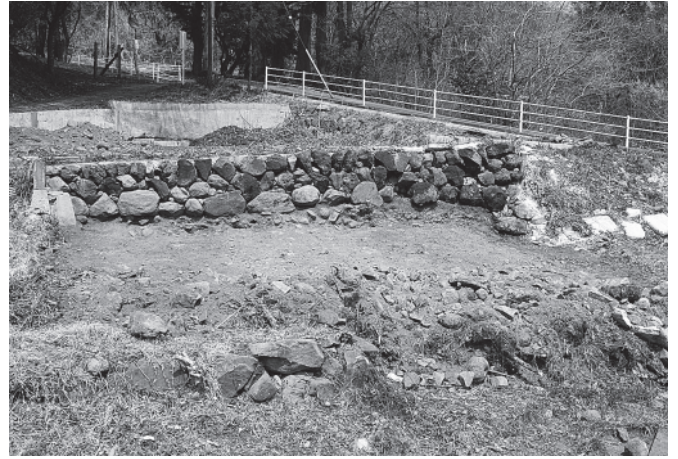
2 2号トレンチ 南から
