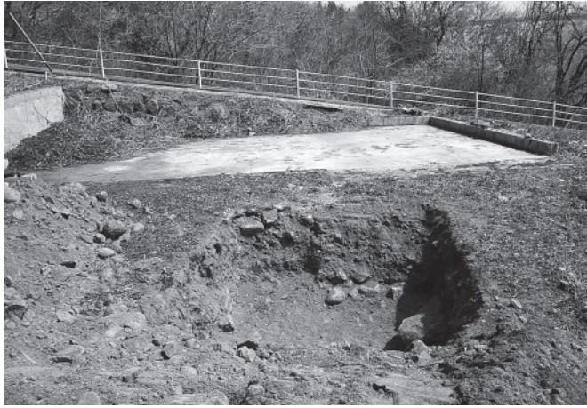
1 1号トレンチ 南東から
