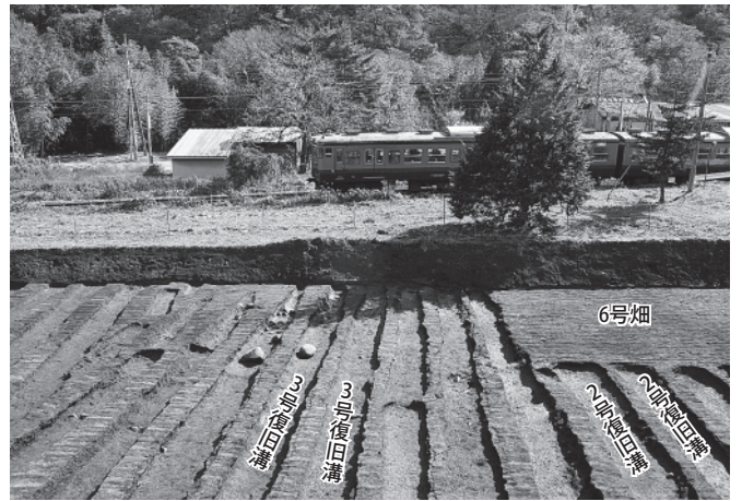
3 2・3号復旧溝 北西から
