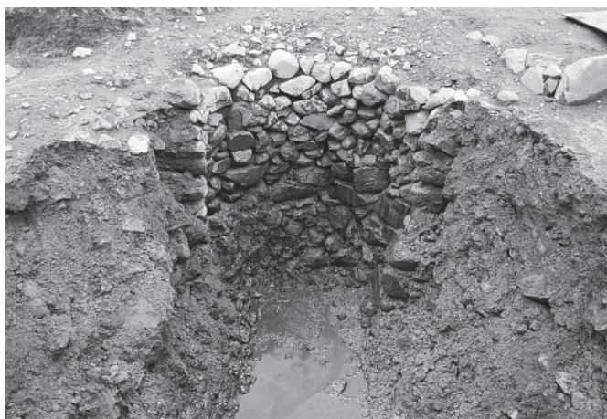
5 1号井戸断面 南から
