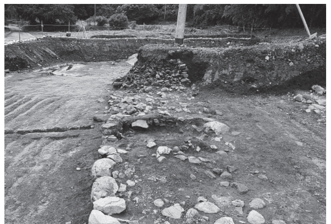
8 18号石垣 東から
