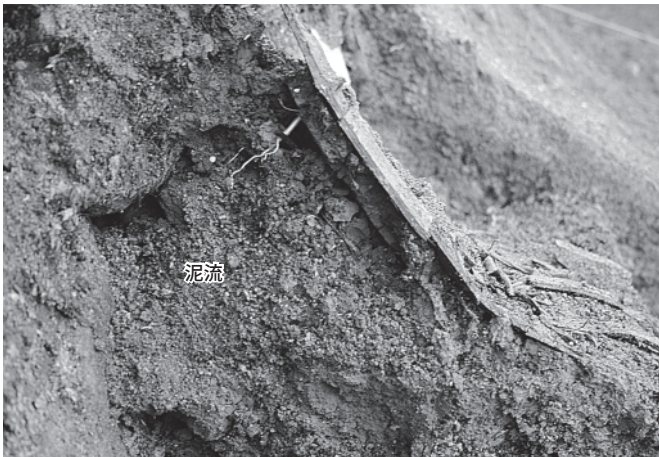
4 2号建物北側雨落溝上の泥流、炭化材、壁材 西から
