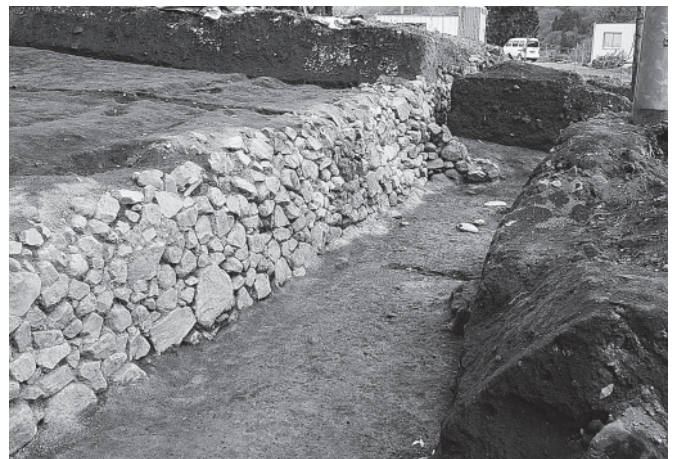
3 12号石垣 南西から
