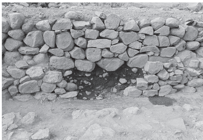
5 16号石垣 南から
