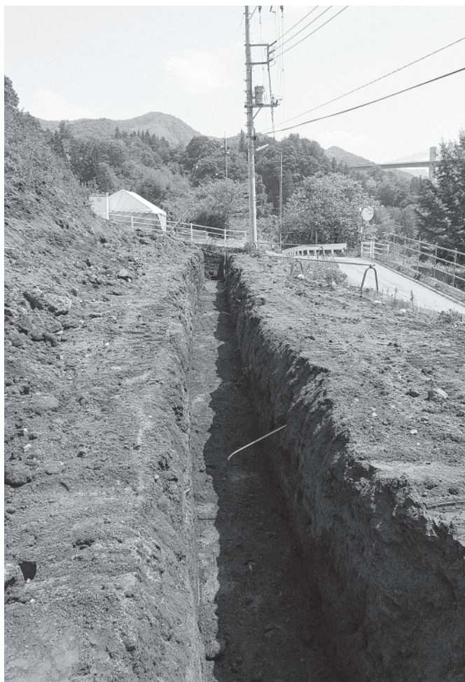
7 11号トレンチ 南西から
