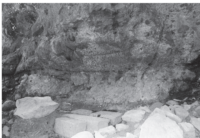
7 1号石造物1b号石造物 南東から
