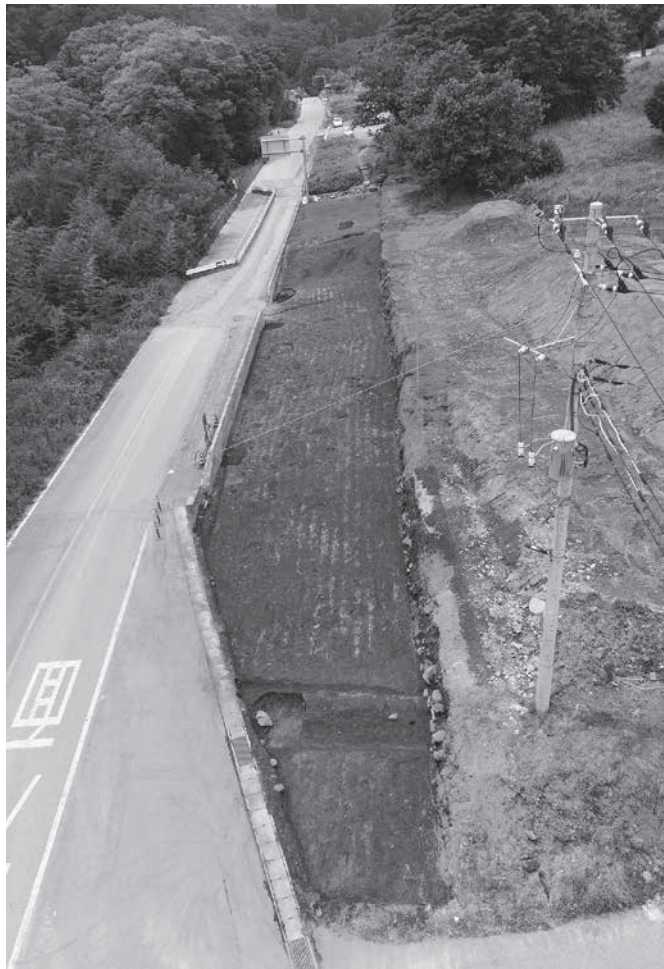
1. V区(27年度)1面全景(北東から)
