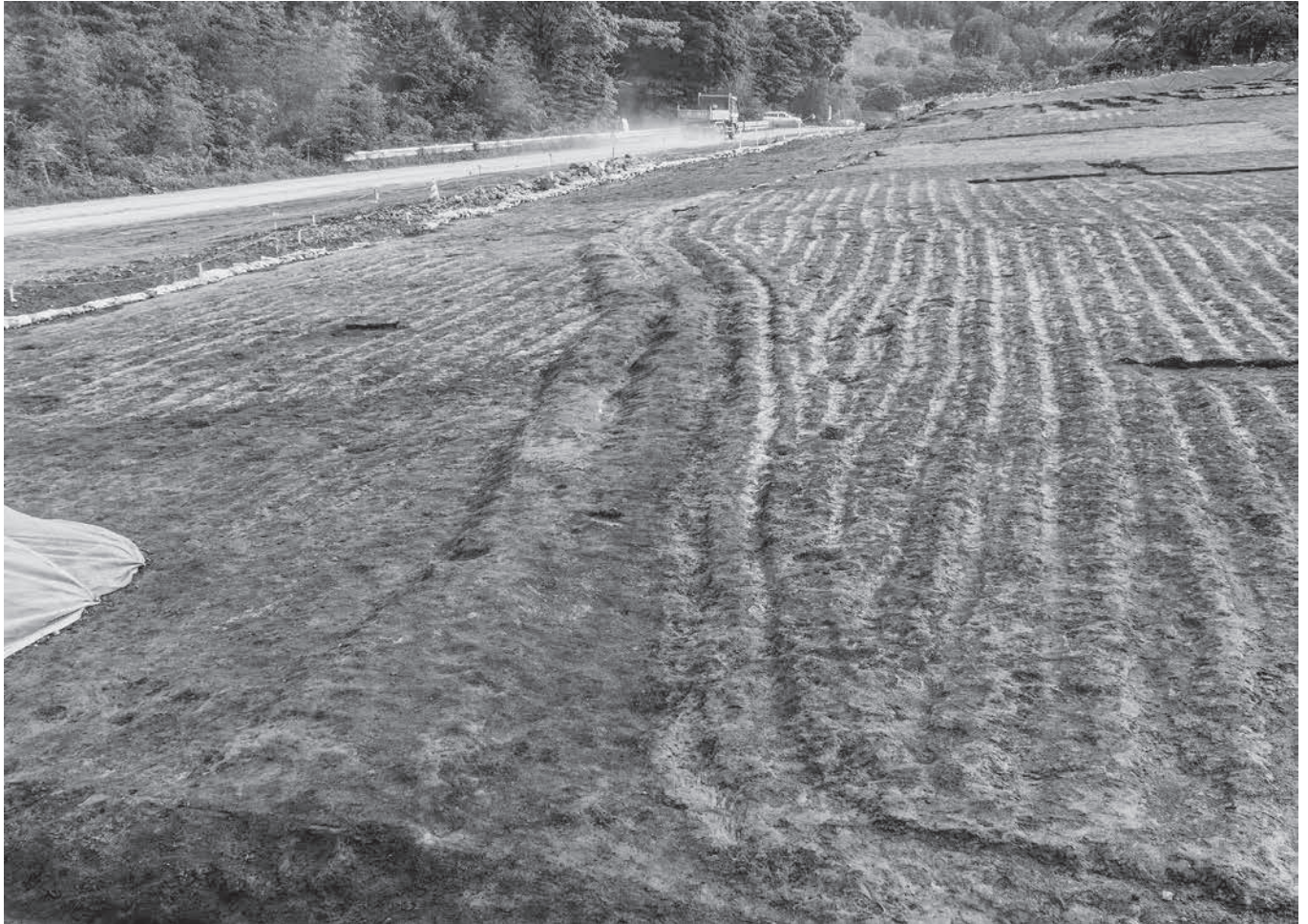
1. 2・3号道路全景(北東から、南に2号畑、北に3号畑)
