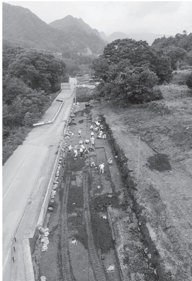
2. V区(27年度)2面調査風景(北東から)
