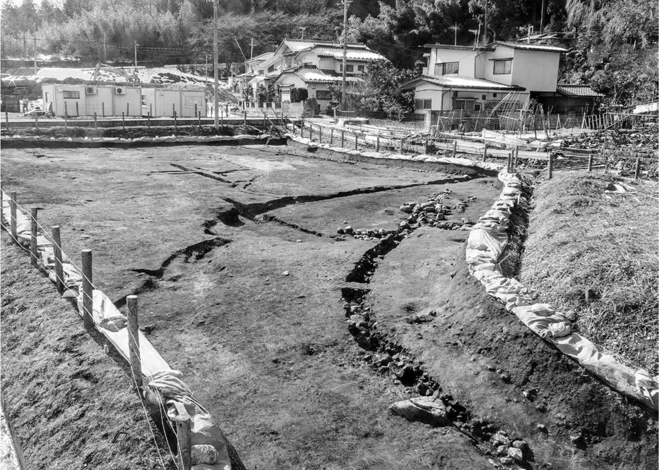
1. 1区1面全景(上段)(北から)
