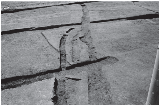
5 B区1面 2~4号溝 全景(北から)
