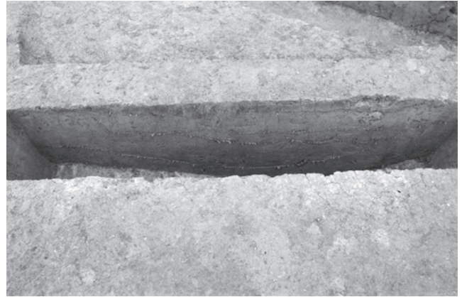
2 0区 9号溝 覆土セクション (南東から)
