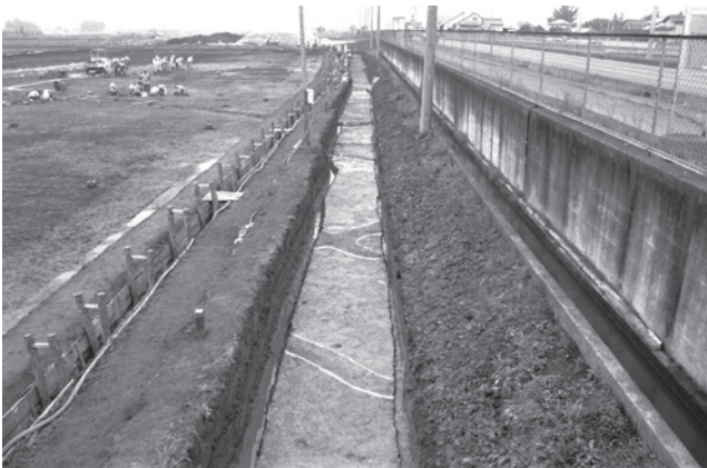
5 E区3面 全景 (東から)
