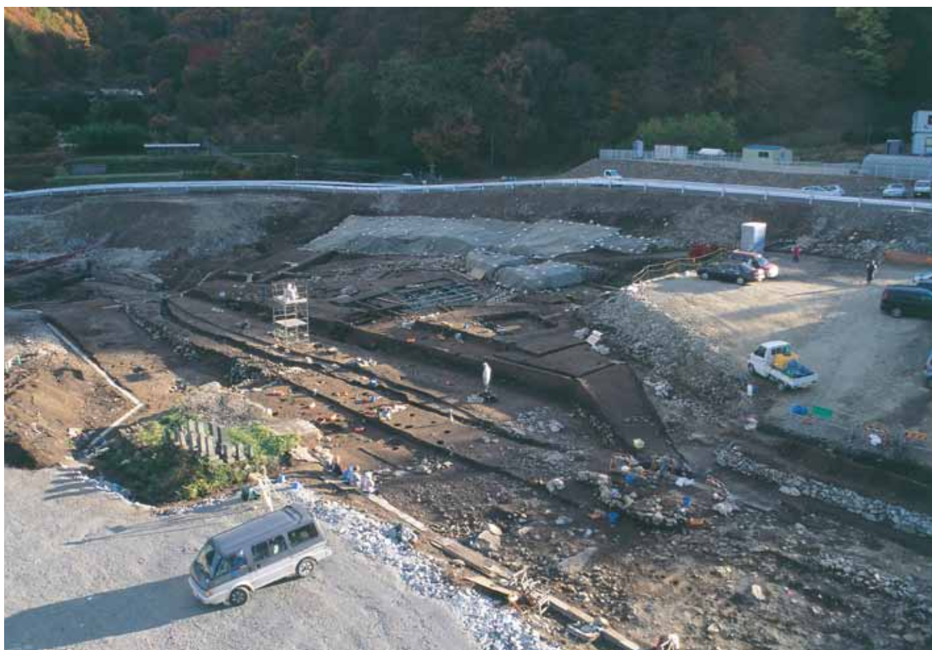
観音堂区調査風景(平成17年度) 観音堂南半や1号塚の調査である
