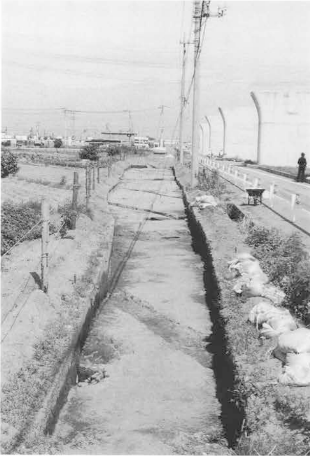
1. B 2 区全景(南東から)
