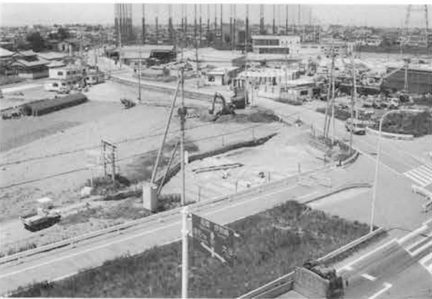
3. B 3 区畠跡(東から)
