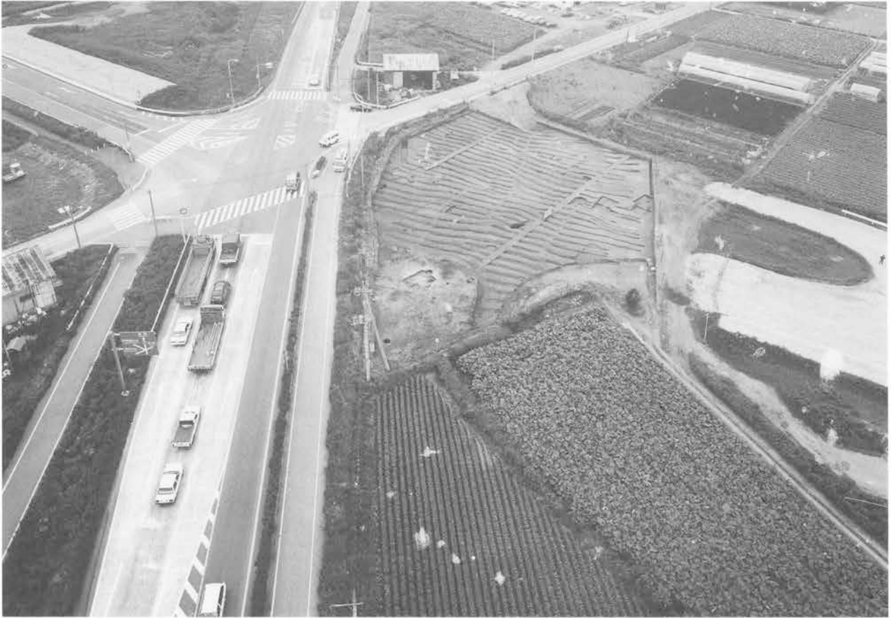
1. A6区北区周辺空中写真(南東から)
