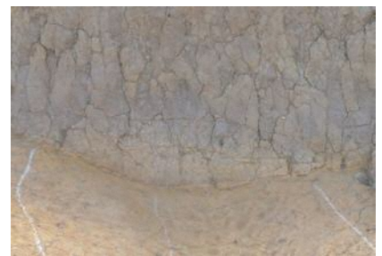
SD8 (南壁内) 北より
