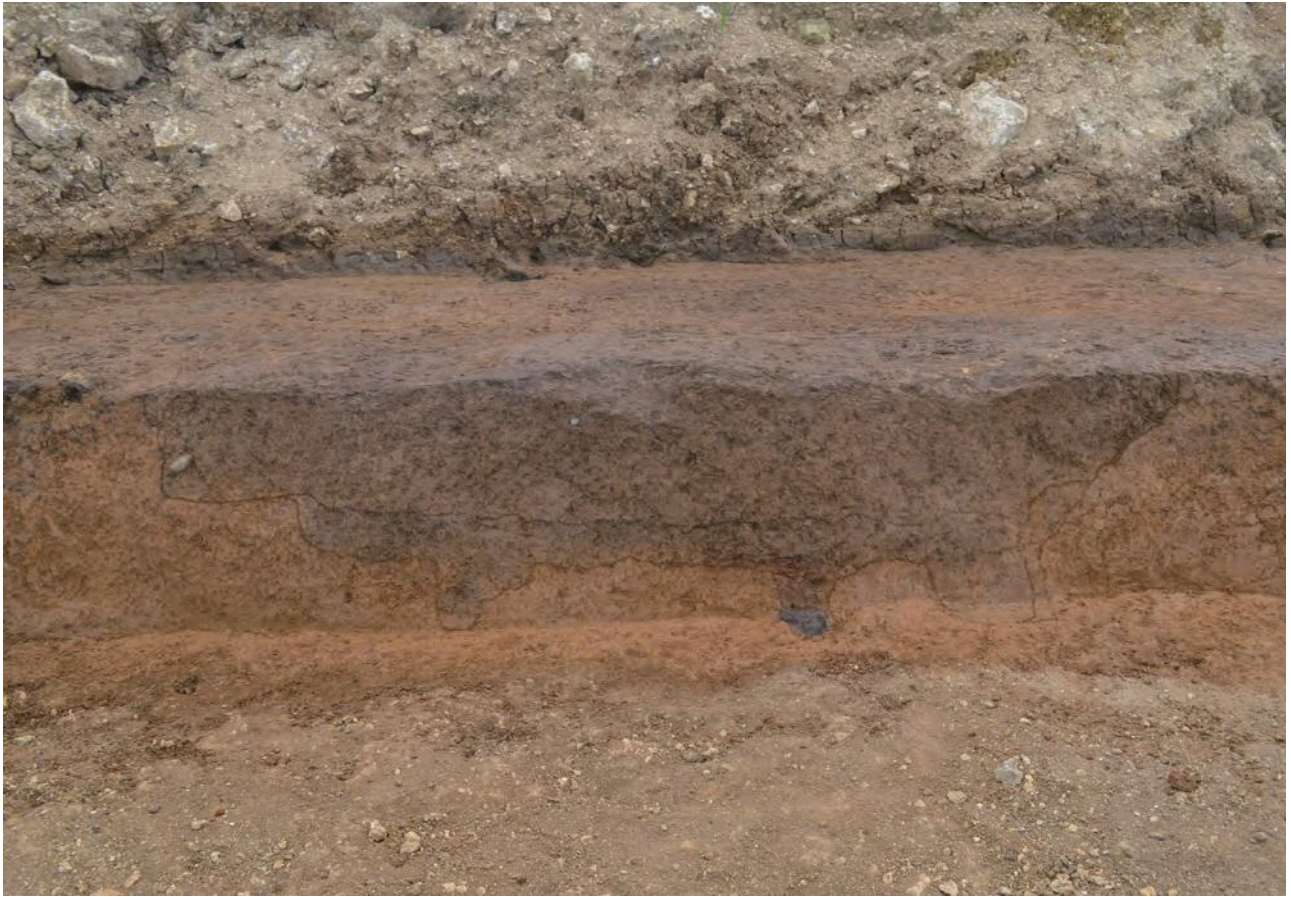
断面状況（北東側から撮影）
