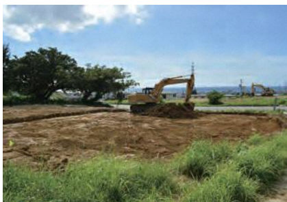
重機掘削（工区2）
