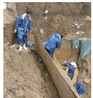
1トレ復旧作業 (11/17)
