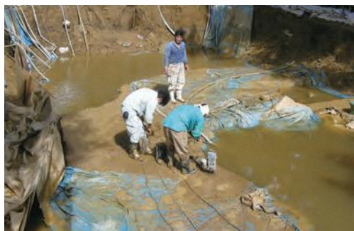
1トレ排水作業 (11/5)
