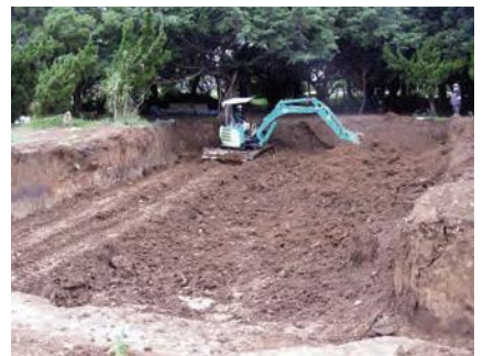
2トレ埋め戻し作業 (11/25)
