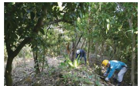
3/26 ハル石周辺伐採作業
