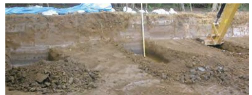
1トレサブトレ掘削状況 (8/6)
