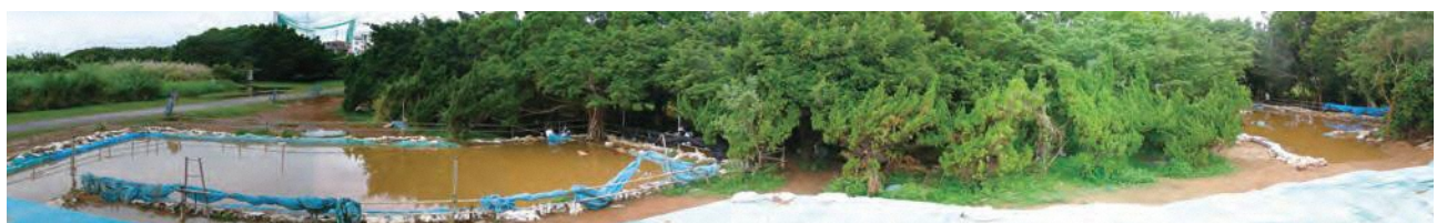
1・2トレ冠水状況 (11/4)
