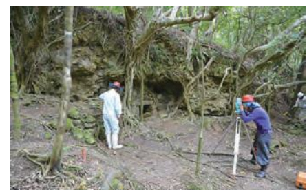
3/24 西11号測量作業
