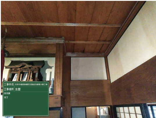
14 空気管設置完了状況（主屋）
