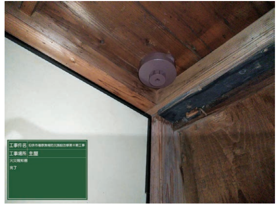
13 火災報知器設置完了状況（主屋）
