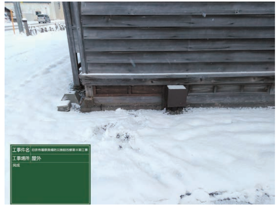
11 火災報知設備設置完了状況（主屋）
