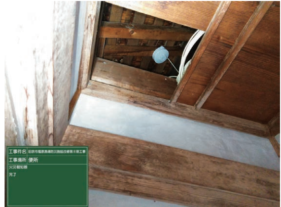
27 火災報知設備設置完了状況（便所）
