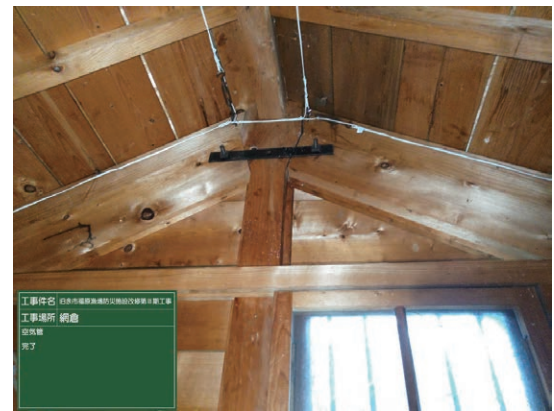
29 空気管設置完了状況（網倉）
