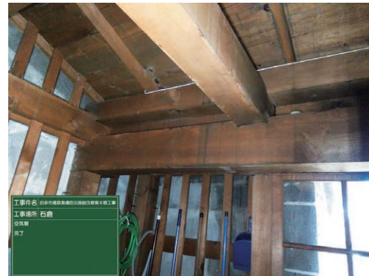
23 空気管設置完了写真（石蔵）
