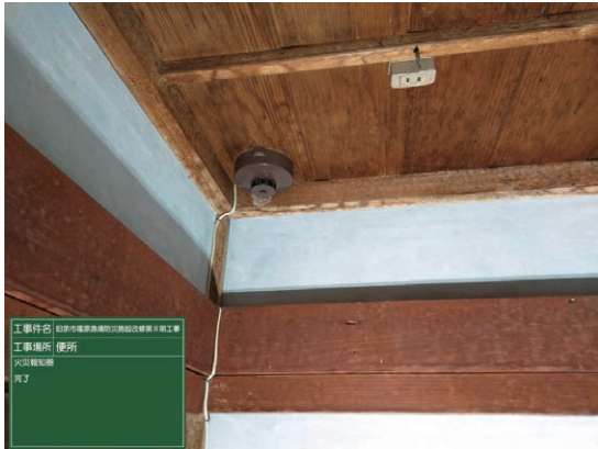
26 火災報知設備設置完了状況（便所）
