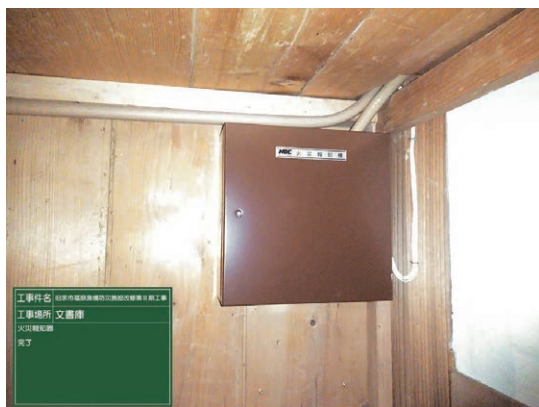
18 火災報知設備設置完了状況（文書庫）
