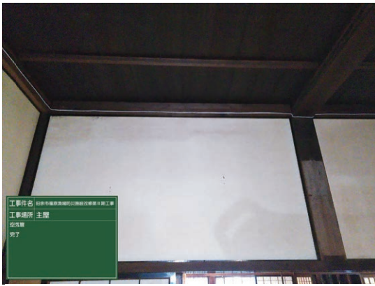
12 空気管設置完了状況（主屋）
