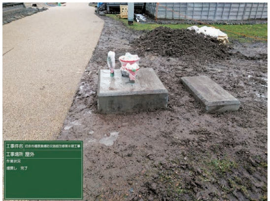
6 消火栓埋設完了
