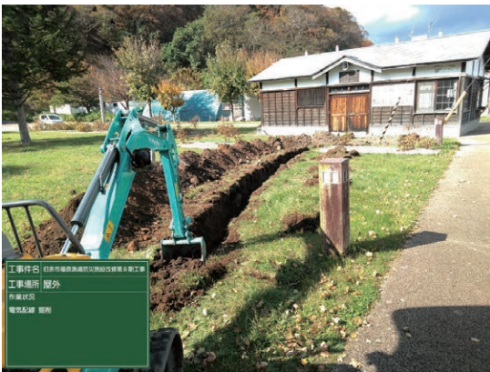
5 電気配線掘削状況
