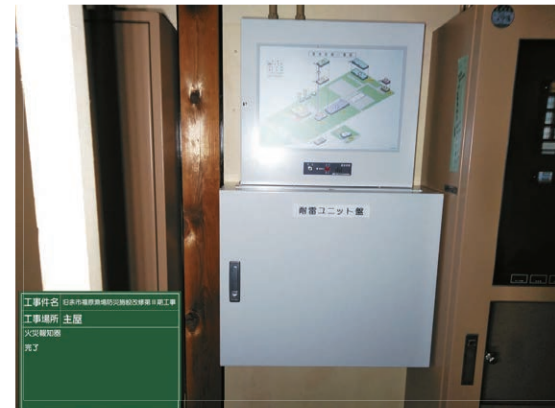
16 副受信盤設置完了状況（主屋）
