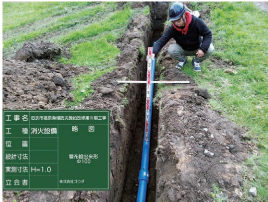
1 消火用配水管設置状況
