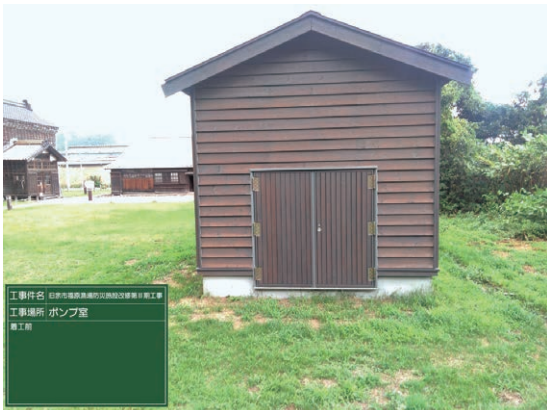
7 ポンプ室設置状況
