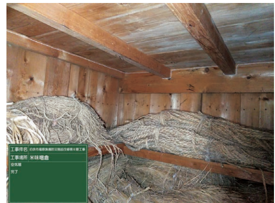
31 空気管設置完了写真（米味噌倉）
