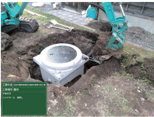
3 ハンドホール設置状況
