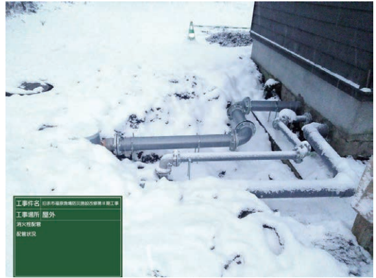
2 消火栓配管状況
