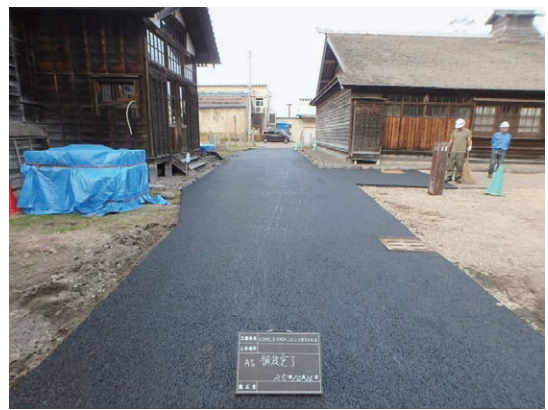
4 舗装完了状況
