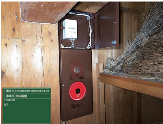
30 火災報知器設置完了状況（米味噌倉）
