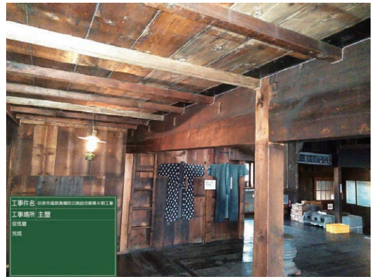
15 空気管設置完了写真（主屋）
