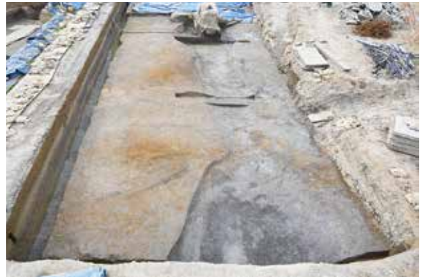
4区 SD4018・SD4019 完堀状況 南から
