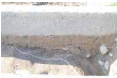
3-1 区 SD3041a-a' 断面 南から
