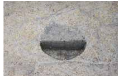
3-4 区 SB3402-SP3619 断面 東から
