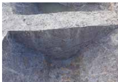
1-2 区 SD3039 b-b' 断面 南東から
