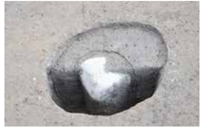
3-1 区 SB3103-SP3331 断面 西から
