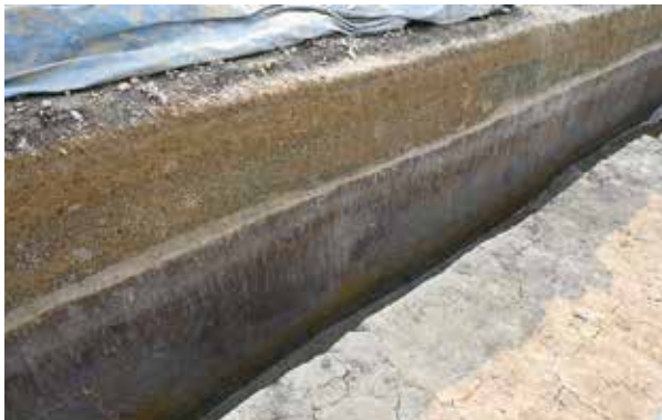
4区 西壁 (SD4018・SD4019 部分) 東から
