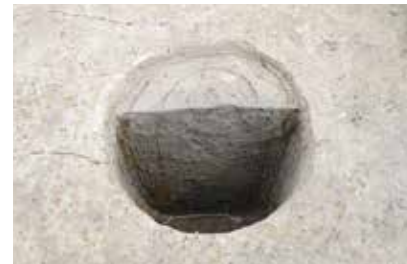
3-1 区 SB3101-SP3265 断面 北から
