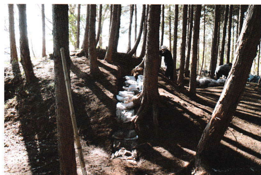
埋め戻し作業
