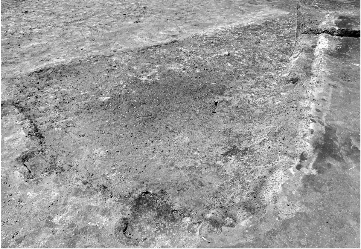
SW01 検出状況
