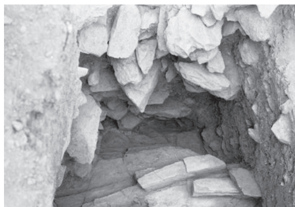
3. 後円部北トレンチ 石室堀方及び裏込め検出状況②
