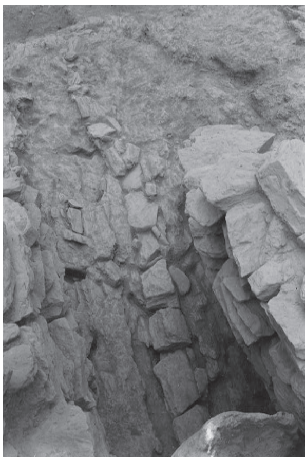
1. 羨道排水溝検出状況（西から）
