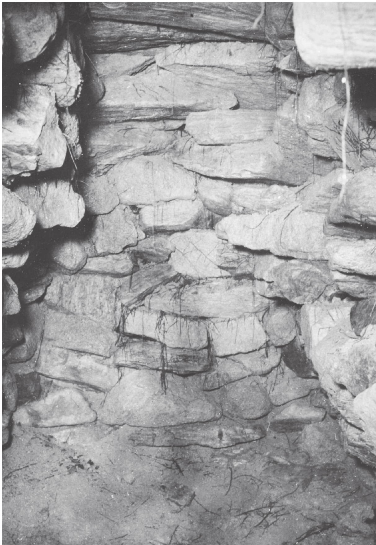
西壁〔第1次調査〕
