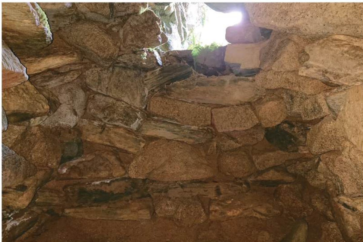
1. 西壁正面観 [平成 16 年撮影]
