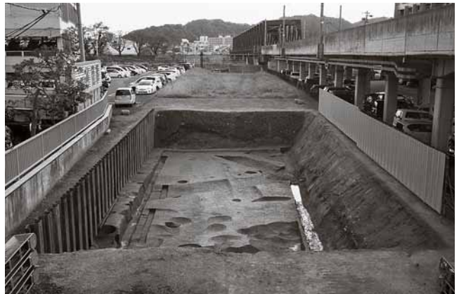
(6) 161-2調査区全景 3面目 (北から)
