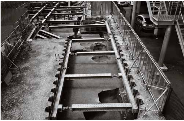
(1) 161-1調査区全景 1面目 (北から)
