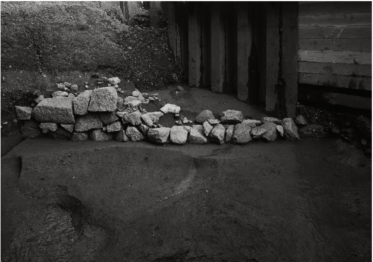
(2) 割場西面石垣（南から）
