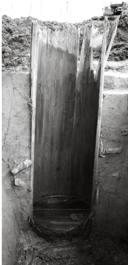
(5) 井戸 154-9 井戸側半裁状況 (南西から)
