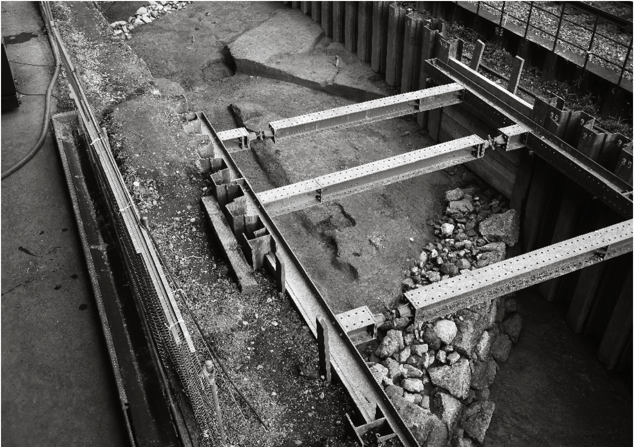
(1) 土橋遠景 (西から)
