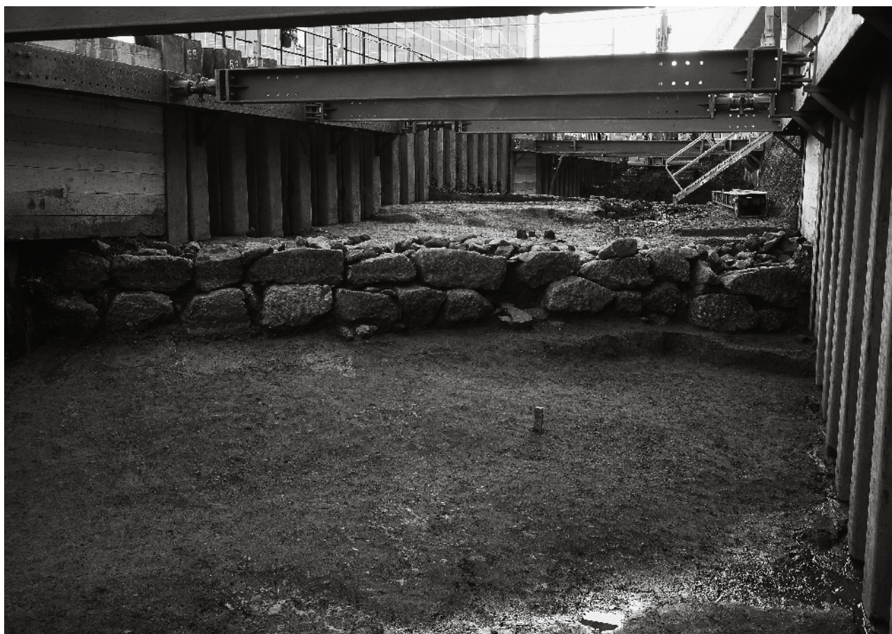
(1) 土橋北面石垣 (北から)
