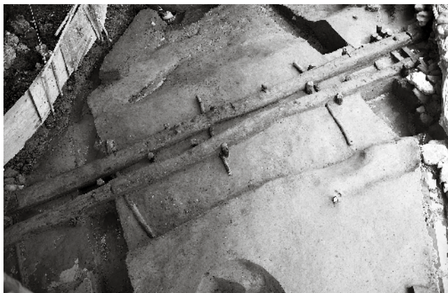
(4) 割場北面石垣 154-12 胴木検出状況 (南西から)
