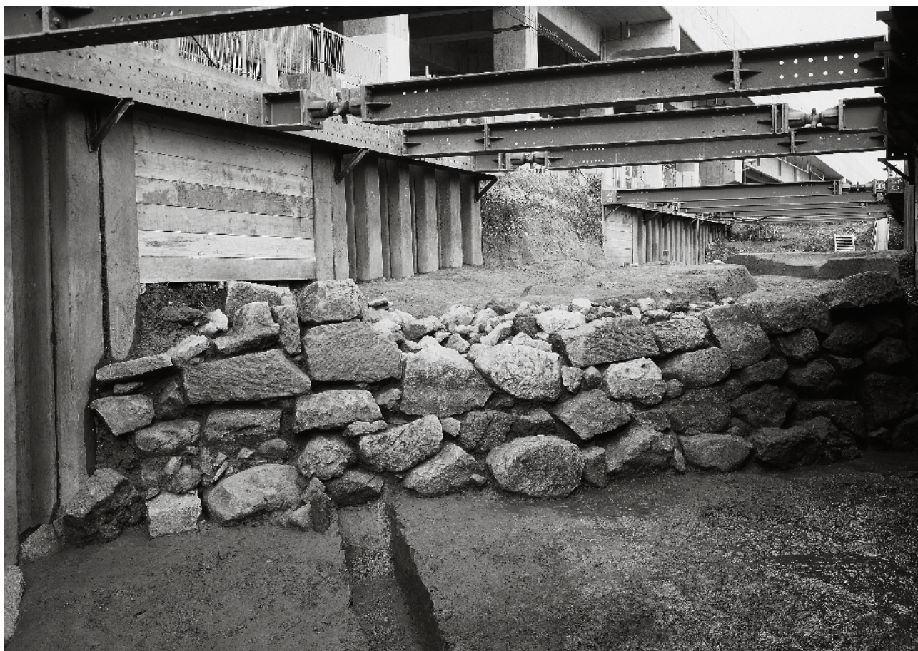
(2) 土橋南面石垣 (南から)
