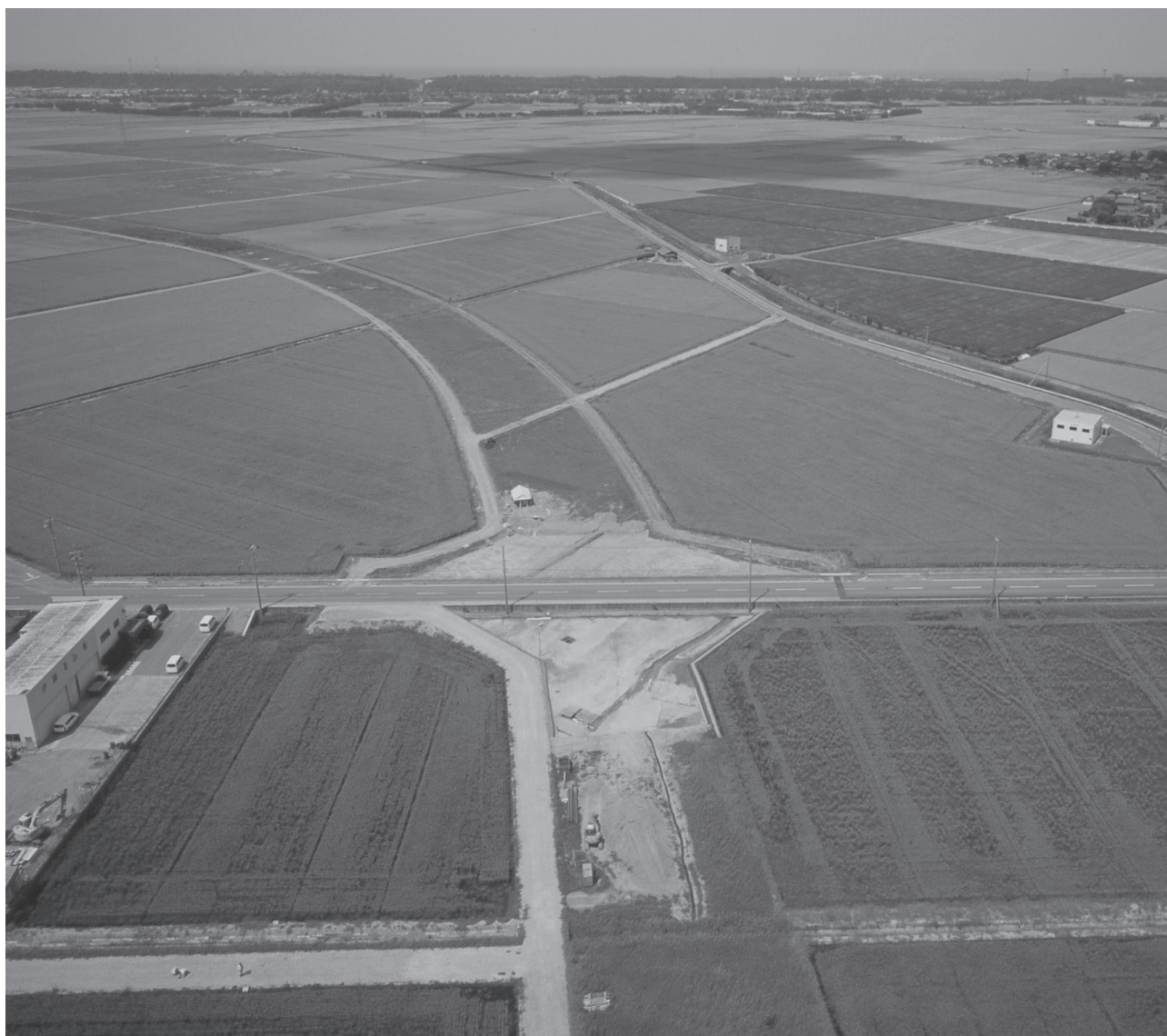
(1) 第IV区域一區 (南から)
