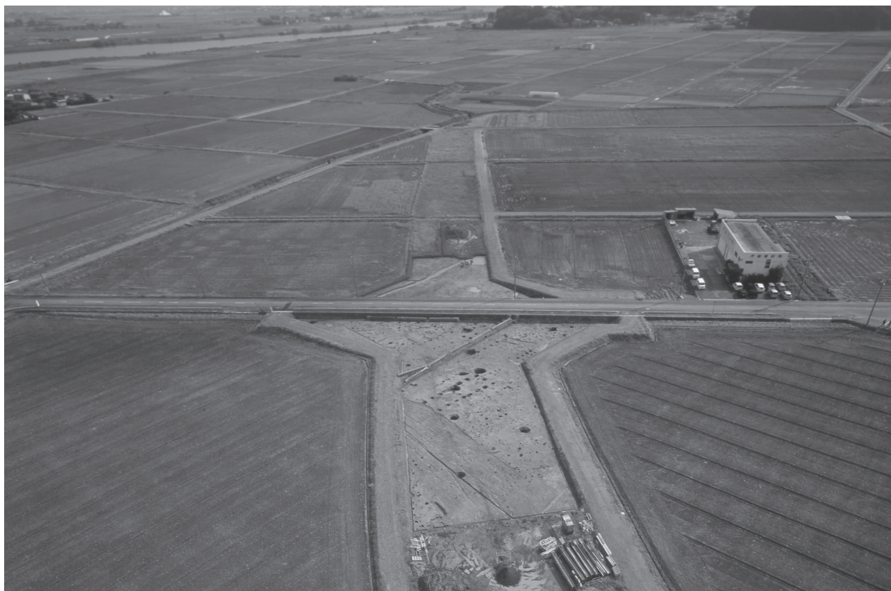
(2) 第Ⅲ区域2・3区 (北西から)
