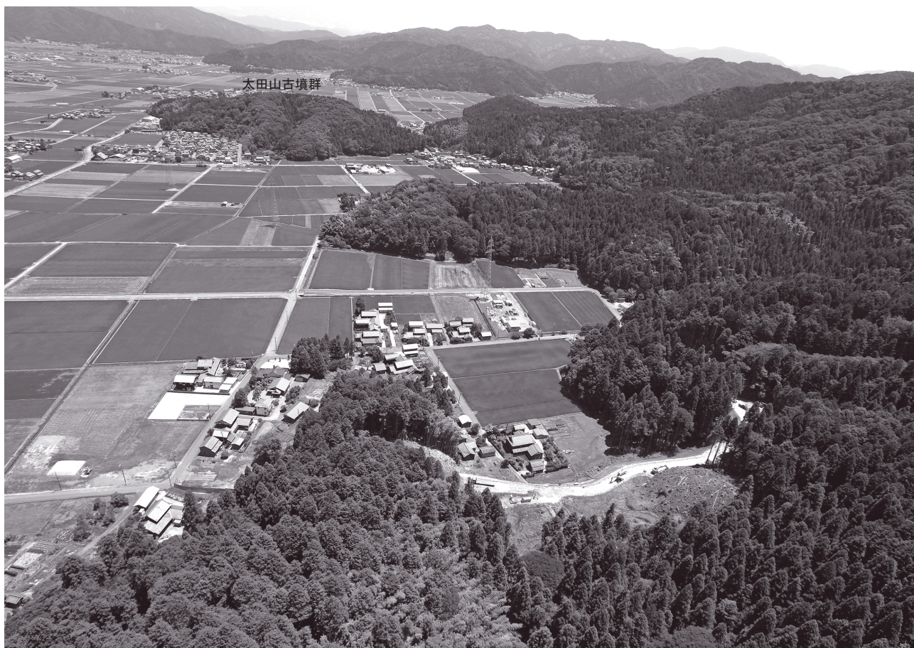
(1) 調査地遠景 (西上空から)
