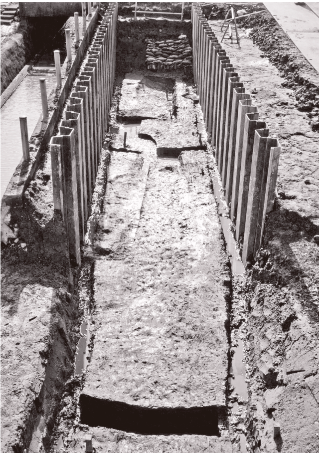
(3) 2区12・13グリッド全景 (北より)
