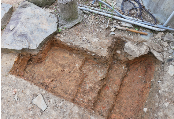
米蔵 TR3 上面完掘状態(北より)
