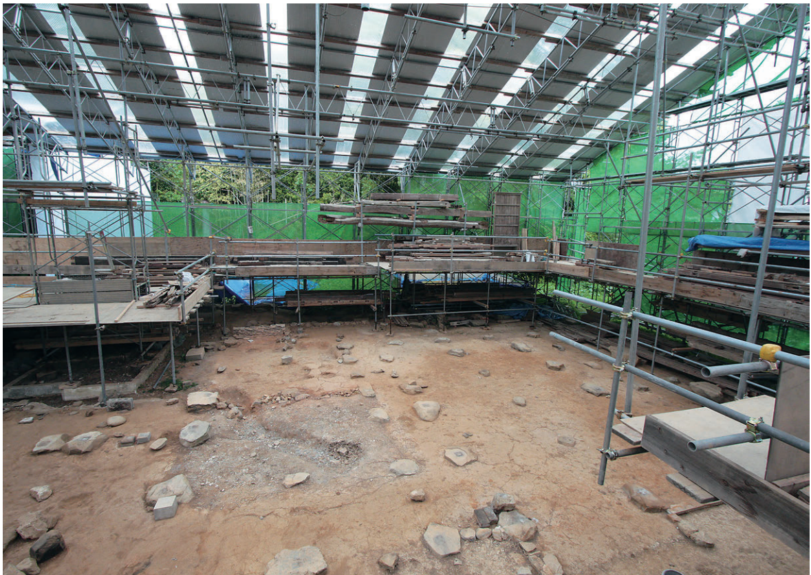
主屋座敷部調査前風景(北より)
