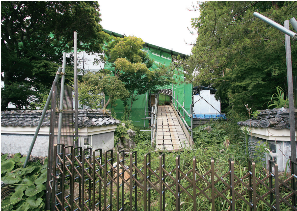
主屋覆屋設置状態(南より)
