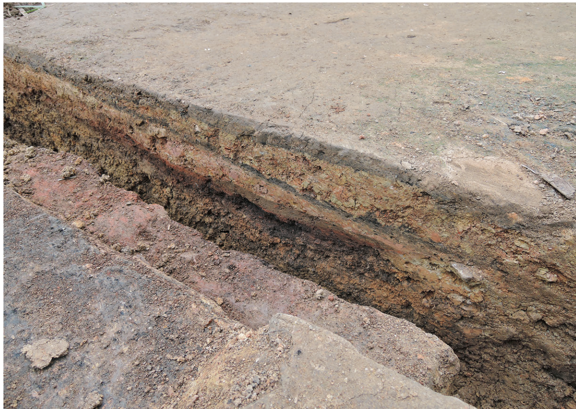
釜屋 TR3 東壁セクション(南西より)
