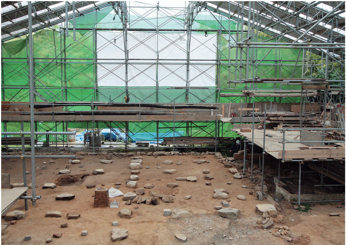
主屋居室部調査前風景(南より)
