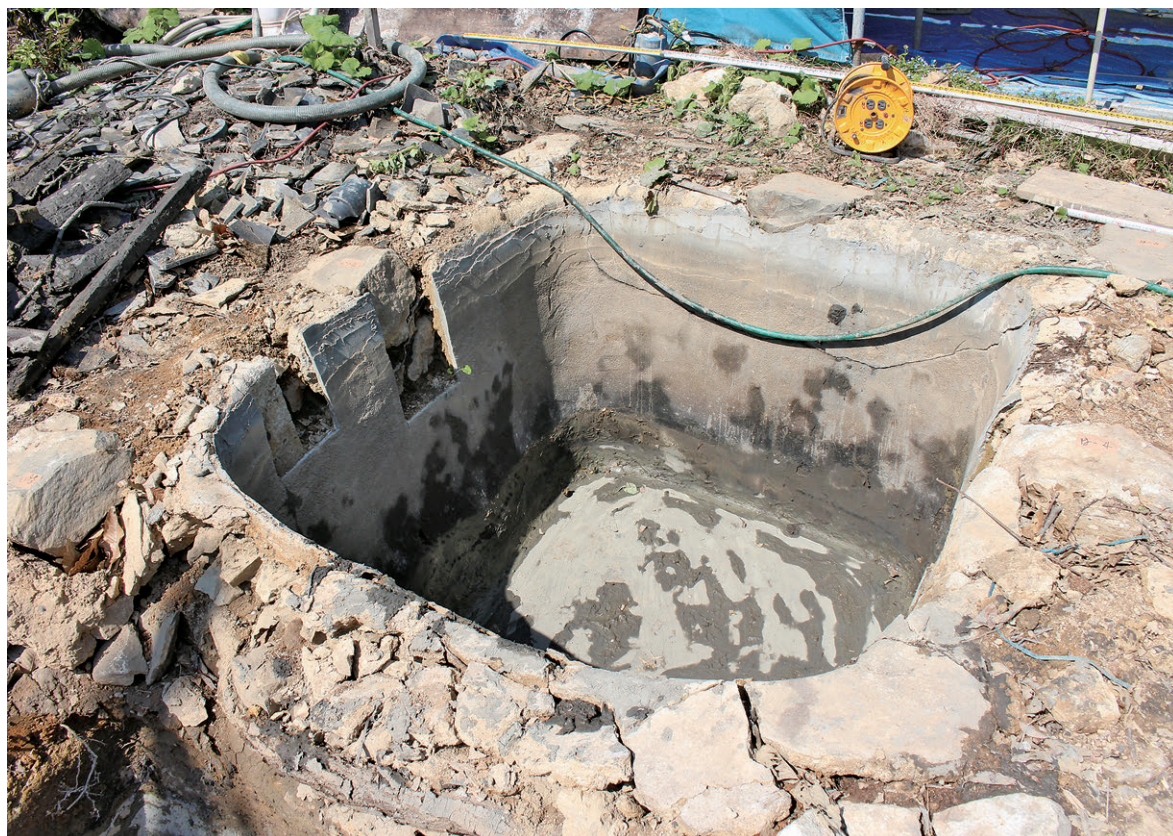
雪隠北部完掘状態(南東より)
