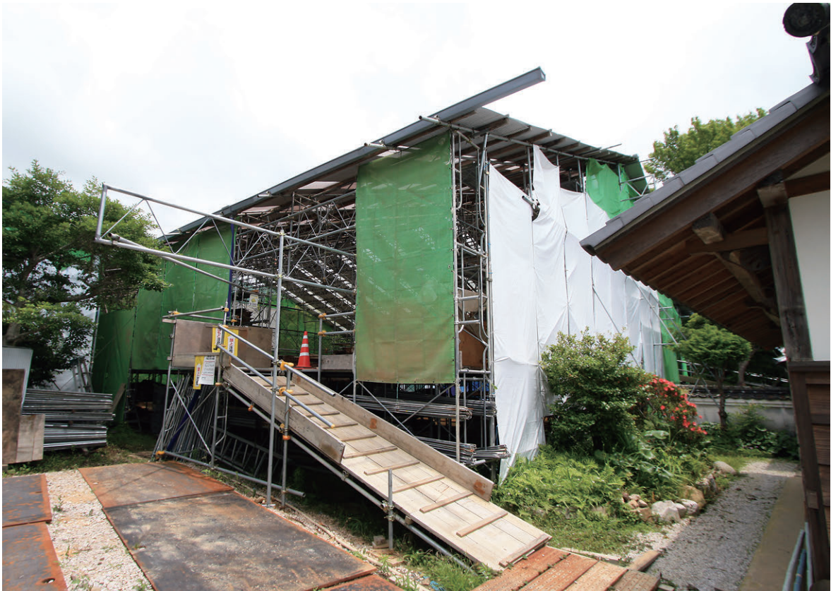
主屋覆屋設置状態(南西より)
