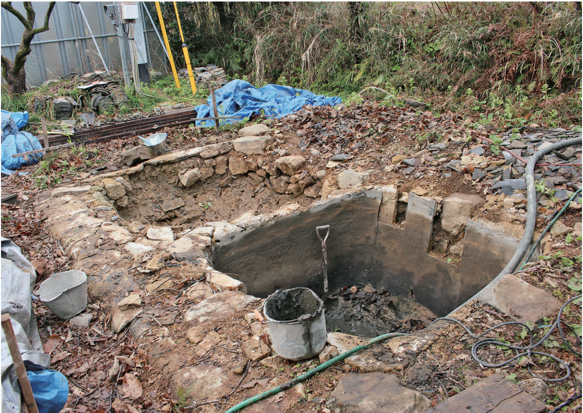
雪隠掘削状態(北東より)
