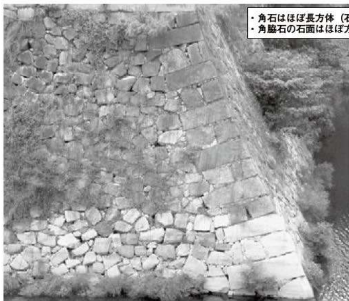
① 大坂城 1 期西外濠隅角部 (東から)
