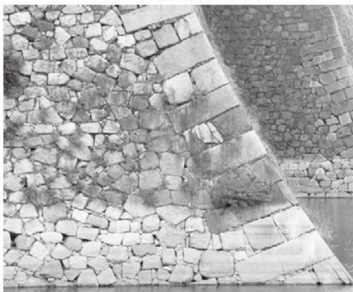
④ 同左、隅角部下部拡大（北から）
