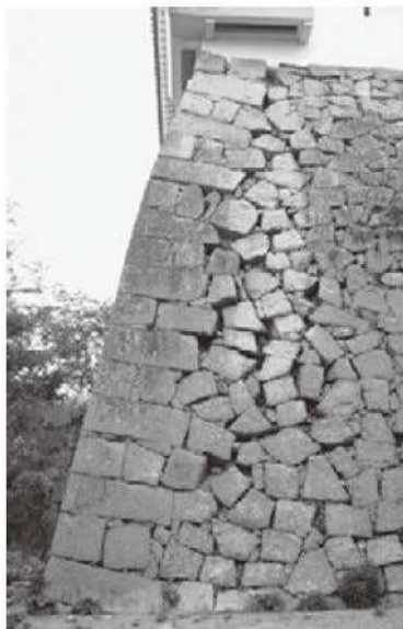
① 天守台南西隅角部 (南面)
