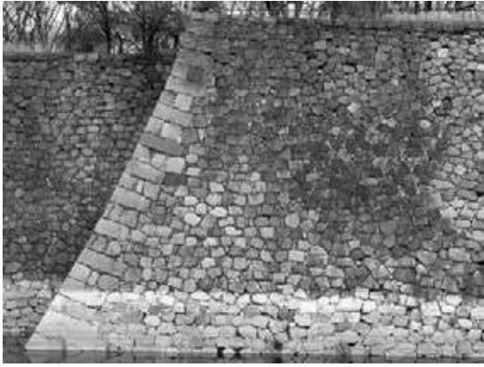
① 大坂城 1 期加藤家丁場 (西の丸西面隅角部 [ 西外堀 ])
