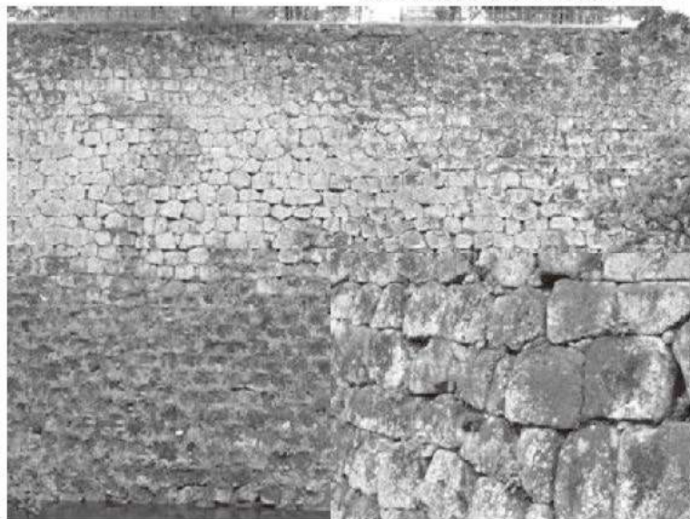
③ 若松城加藤家改修部分（本丸東面築石部）
