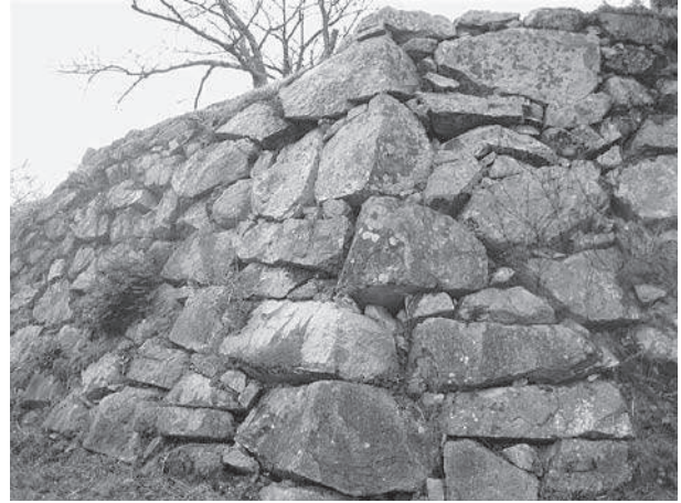
写真 14 但馬竹田城 (本丸西面石垣シノギ積み)
