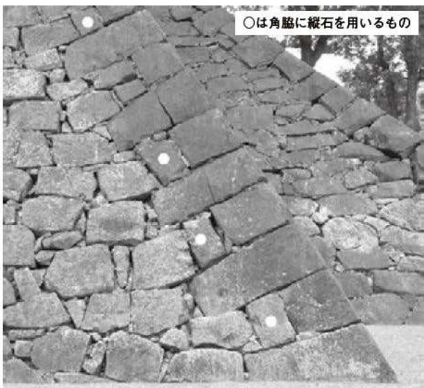
写真1 参考：熊本城細川期石垣(本丸南西隅 [二様新石垣])
