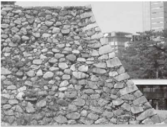
⑤ 高松城（本丸天守台北東隅角部） ※解体前
