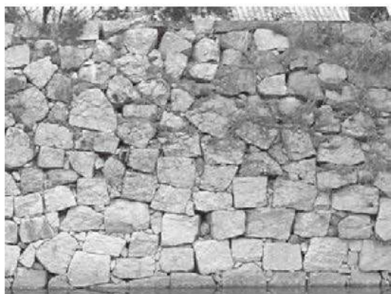
⑧ 洲本城蜂須賀家改修部分（下の城北面築石部）
