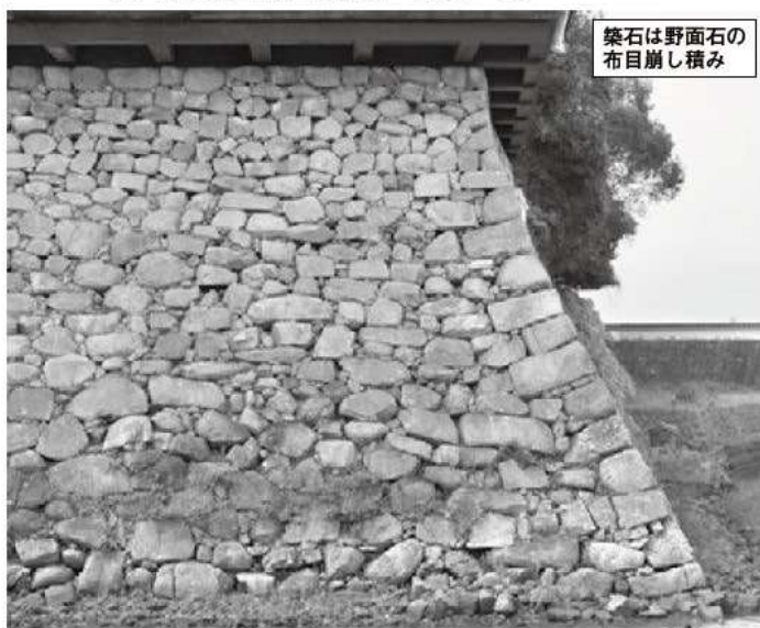
③ 本丸北東隅角部 (東から) ※上半部は改修
