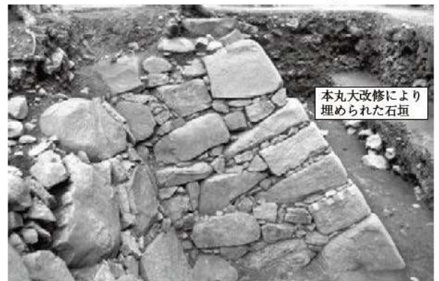
⑥ 名護屋城本丸旧石垣隅角部 本丸大改修により 埋められた石垣 割石による控えの短い 算木積み
