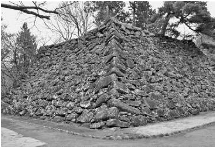
写真 32 小諸城 天守台石垣北西隅角部
