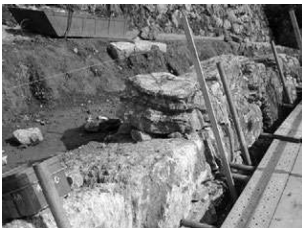
写真17 高知城本丸修復石垣
