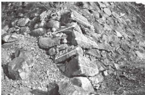
⑦ 名護屋城三ノ丸南東櫓台隅角部 割石(粗割石)による 控えの長い算木積み
