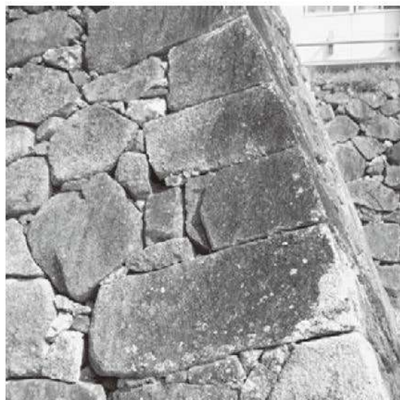
② 同左、角石の表面調整 (南から)
