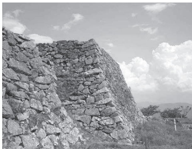
写真 13 但馬竹田城 (天守台隅角部)
