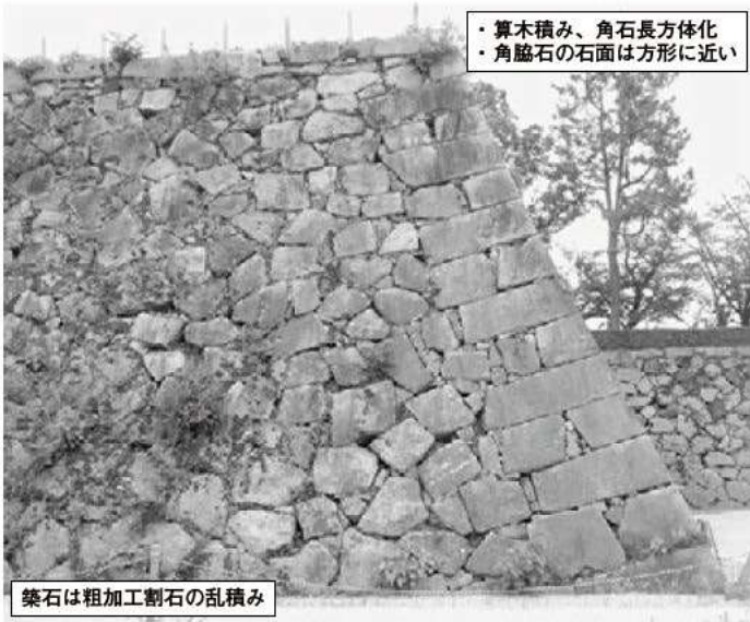
① 天守台北西隅角部（北から）
