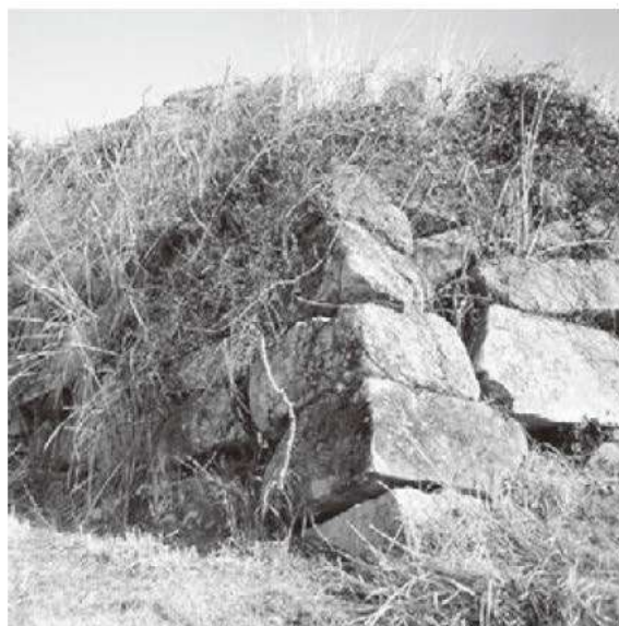
② 竹島倭城隅角部 (角石の控えは短い)
