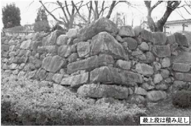
① 田辺城天守台隅角部 横長の石材で左右に控えの長い算木積みとする
