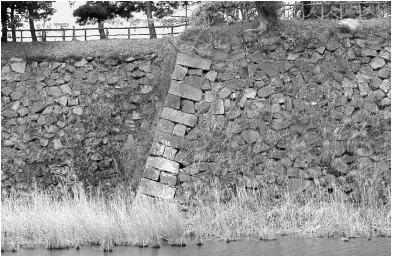
4b 二之丸北隅角部
