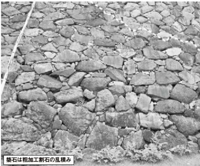
③ 本丸西南隅櫓下築石部 (点線より上は改修部分、西より)
