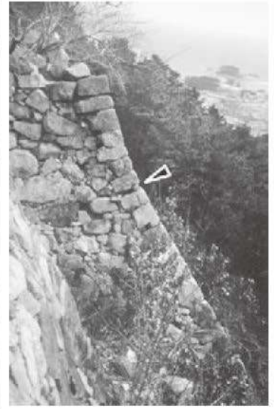
② 左写真と同一箇所
