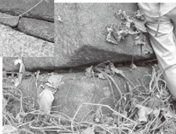
③ 大坂城 2 期藤堂家丁場（左：胴張りの様子、中：加工された間詰め石、右：間詰め石のための角石への加工）
