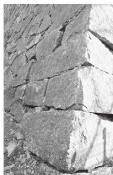
④ 同北西隅角部（表面調整少ない）
