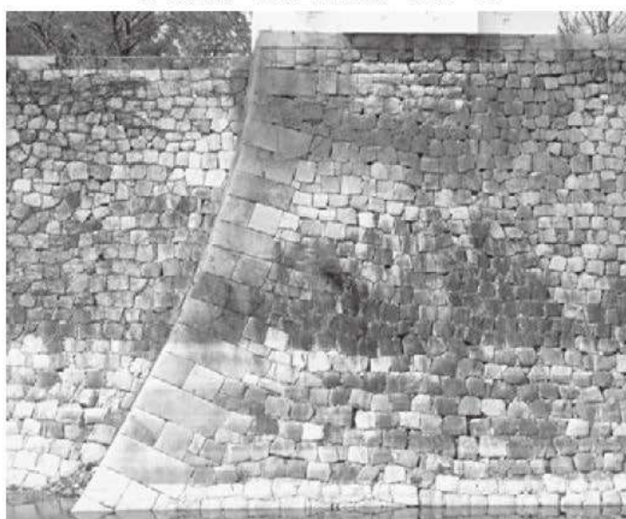
③ 南外濠一番櫓下隅角部（東から）
