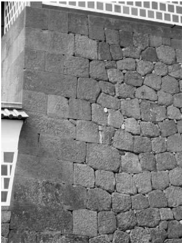
上部（文化期）隅角部（解体・修築後）
