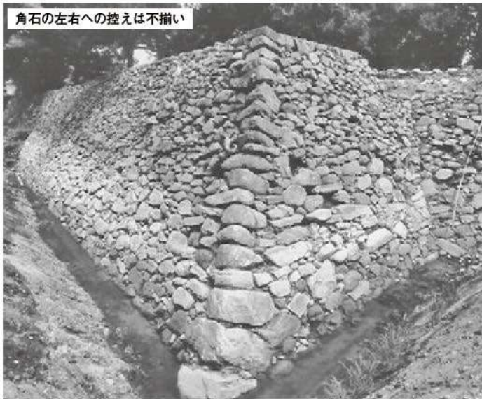
① 本丸南西面石垣隅角部 (南東から) ※上半部は積み直し
