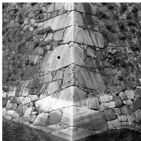
③ 西外濠千貫槽下隅角部 (熊本藩加藤家) 左：西面、右：南西より 角石は大型で、石面を広く見せる意匠的な配置 (●がみられる)
