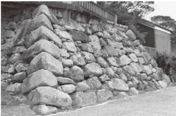
⑤ 中津城本丸鉄門隅角部 転用石の制約もあり控えは短い、算木積みを意識した角石の配置
