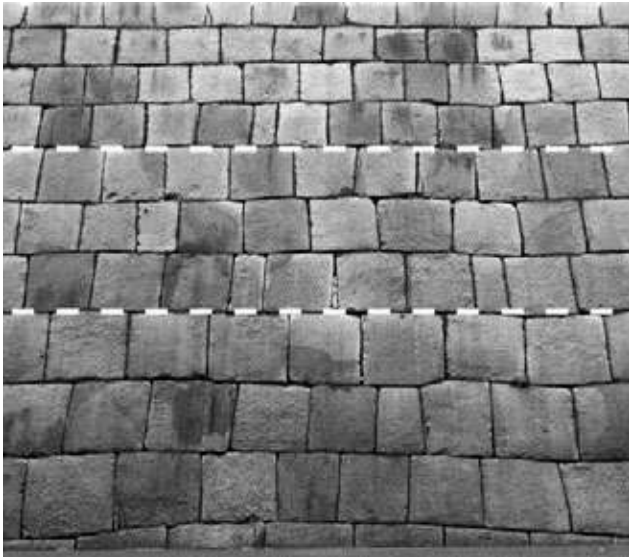
大中小の規格材を用いた四方積（北面）
