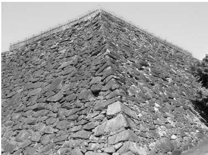
写真25 甲府城 天守台東南隅角部
