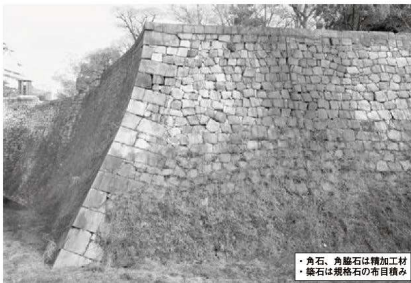
① 本丸西面具足方預片菱槽下隅角部 (西から)
