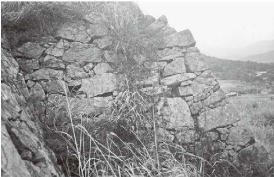
⑤ 同③、左側の隅角部（稜線は僅かに勾配が起きる）
