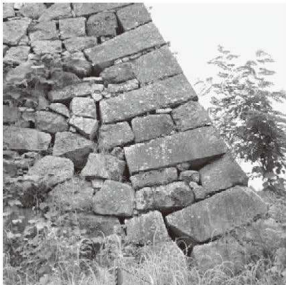
② 同上拡大（東から）
