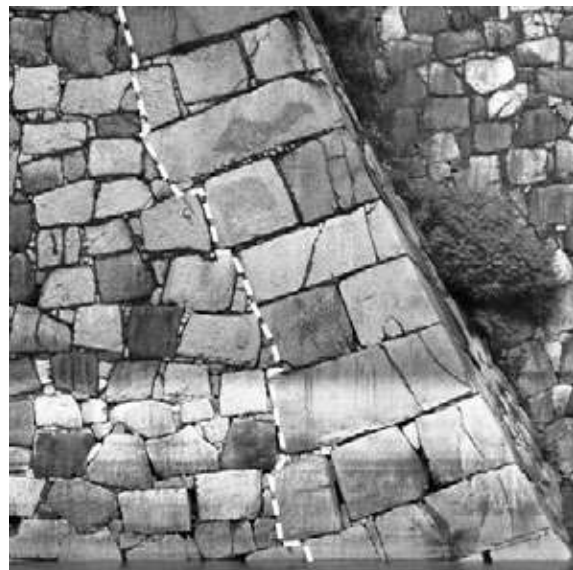
① 西外濠隅角部 (福岡藩黒田家) 左：西面、右：同拡大 隅角部と築石部が噛み合わない部分が多い (「隅角部の独立化」)
