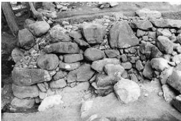
写真 23 武田氏館 天守台石垣西面 (非公開)
