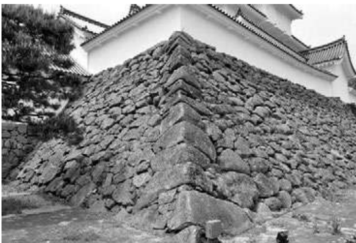
写真 34 若松城 天守台石垣南東隅角部
