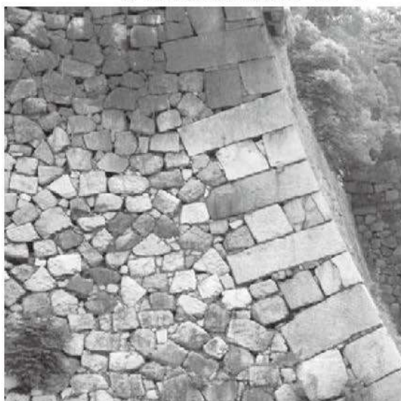
③ 同上、隅角部上部拡大（北から）
