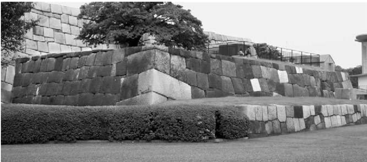
小天守台石垣（南東から）
