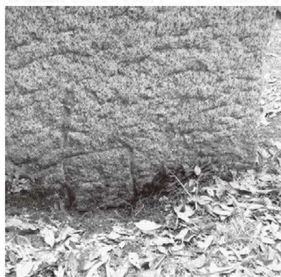
④ 石材No.1の刻印 (小口面に四角形の刻印がみられる)
