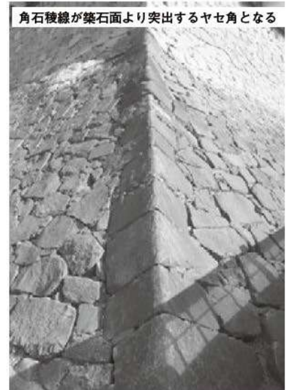
② 同左、稜線部 (北西から)
