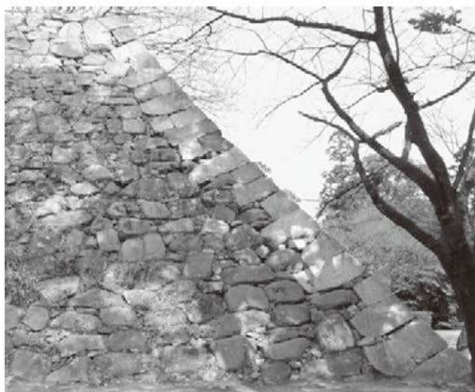
③ 本丸南西隅角部（西から）
