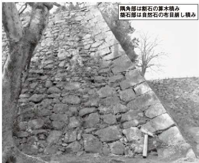
① 本丸南東隅角部（南から）
