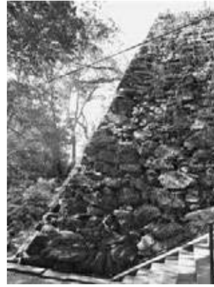
② 徳島城 1期 (本丸北東隅角部)
