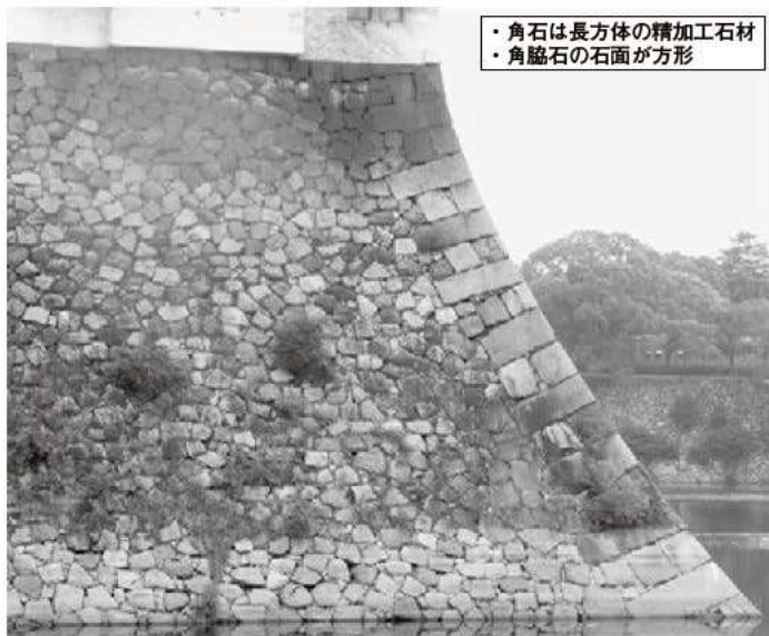
① 西外濠乾槽下隅角部（北から）
