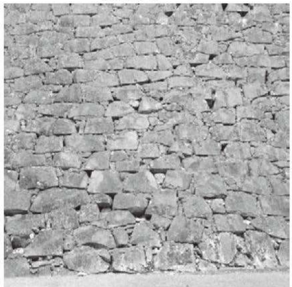
⑥ 同左、築石部 (布目崩し積み [右] と布目積みの両方がみられる)
