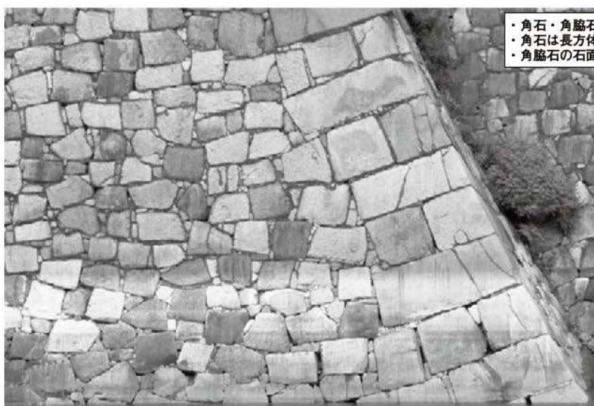
③ 同上拡大 (西から)
