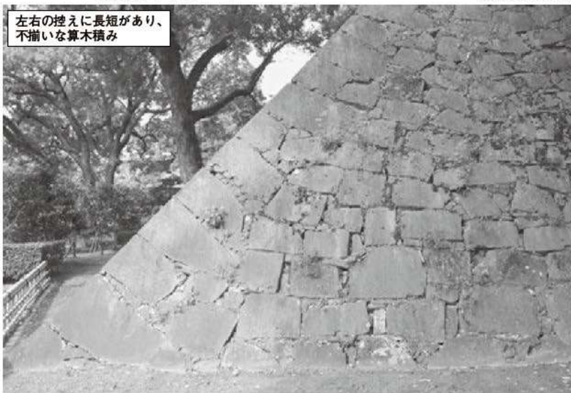
⑤ 田子櫓下隅角部 [B-1類] (東から)
