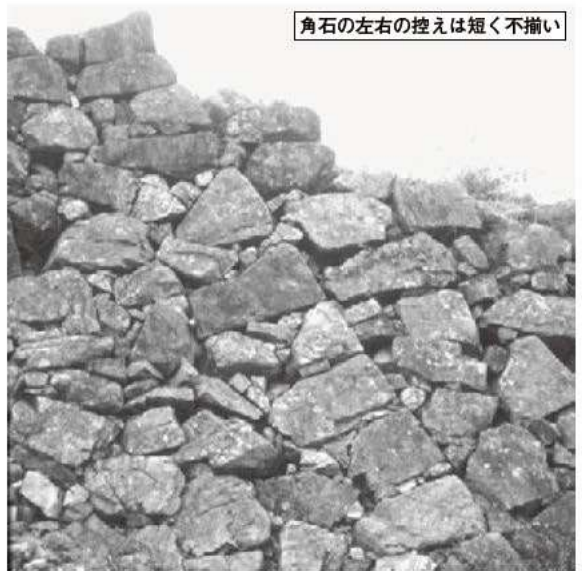
④ 天守台西面（改修により埋め込まれた隅角部）
