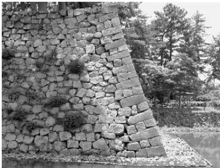
① 津城藤堂家改修部分（本丸北西隅角部）
