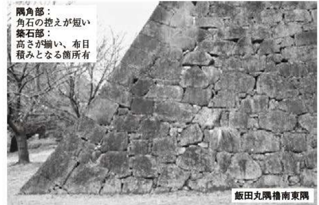
② 熊本城石垣A-2類 ※勾配がA-1類より急である
