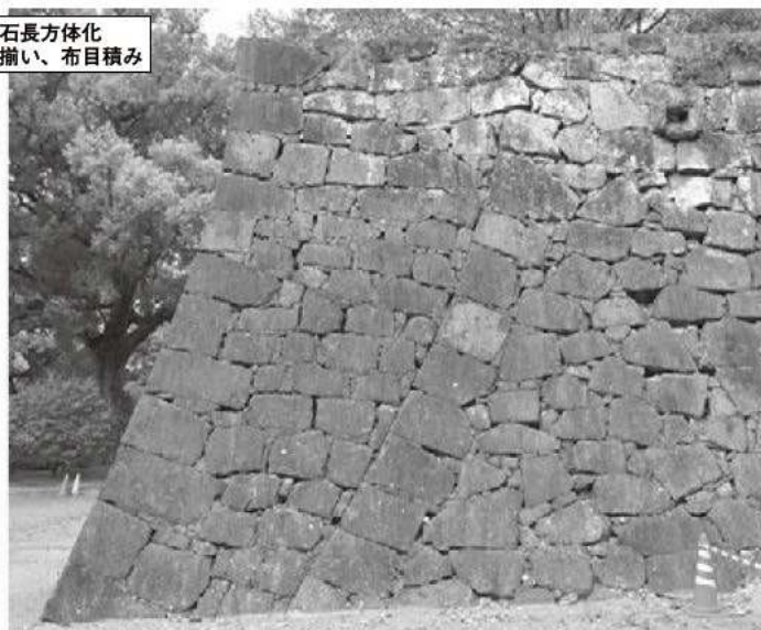
② 同東面 (A-2類 [控えの短い角石] → B-3類 [算木積み] への改修)
