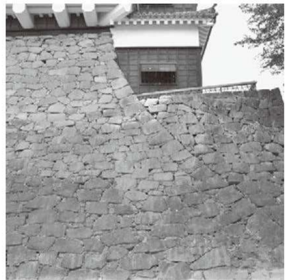
④ 大天守台南東隅角部 (西より)
