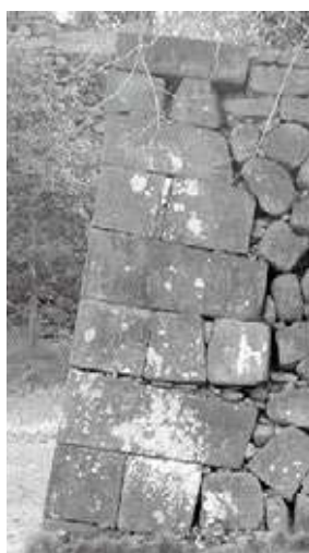
北面東端隅角部
