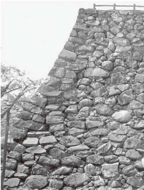
写真 27 甲府城 稲荷櫓台北東隅角部 (熊本型)
