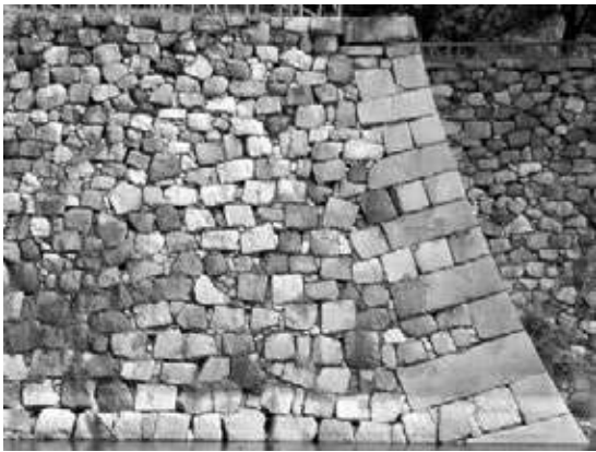
③ 大坂城 1 期生駒家丁場 (二の丸北面隅角部 [ 北外堀 ])
