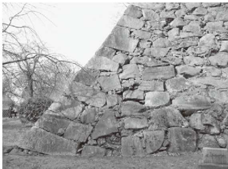
⑥ 本丸鉄砲櫓下隅角部（南から）
