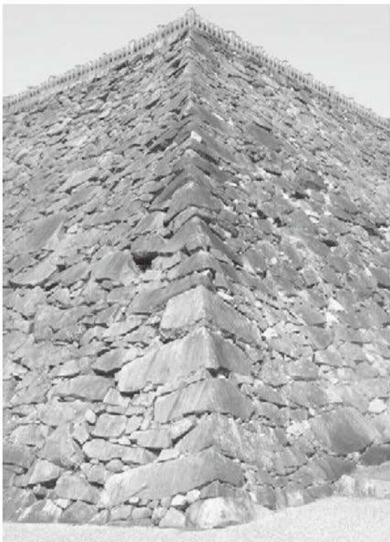
3. 天守台南東隅角部
