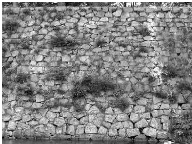
③ 津城藤堂家改修部分（本丸北面築石部）
