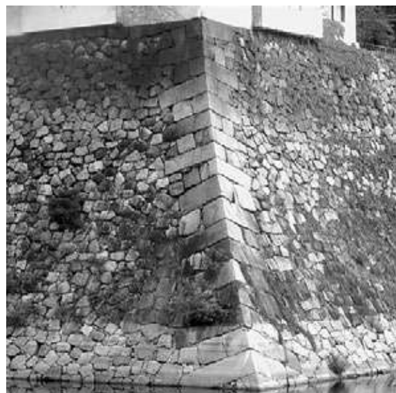
② 西外濠乾槽下隅角部 (小倉藩細川家) 左：北西面、右：北西より 隅角部の角石では高さ比べ控えの長い石材が目立つ
