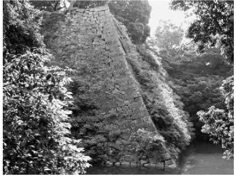
① 上野城藤堂家改修部分（本丸南西隅角部）
