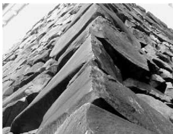
写真 39 甲府城 隅角部稜線作出事例
