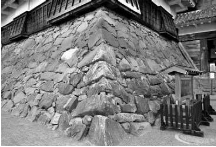
写真 30 松本城 天守台石垣北東隅角部
