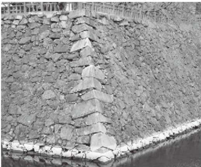
⑤ 本丸西面石垣隅角部（南西から）
