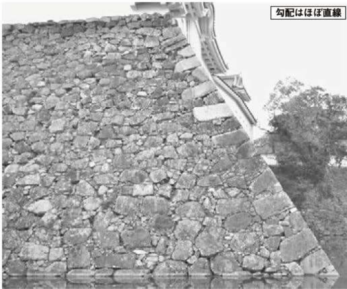
① 天守台北東隅角部 (東から)
