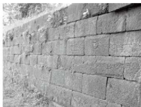
西面中央 (北から)
