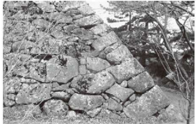
図6 江戸城本丸汐見坂南東隅（左：東面）・富士見櫓台南西隅（右：西面） 隅角部と築石部との境が明瞭な汐見坂に対し、富士見櫓では角石が築石部と噛み合う部分がある。
