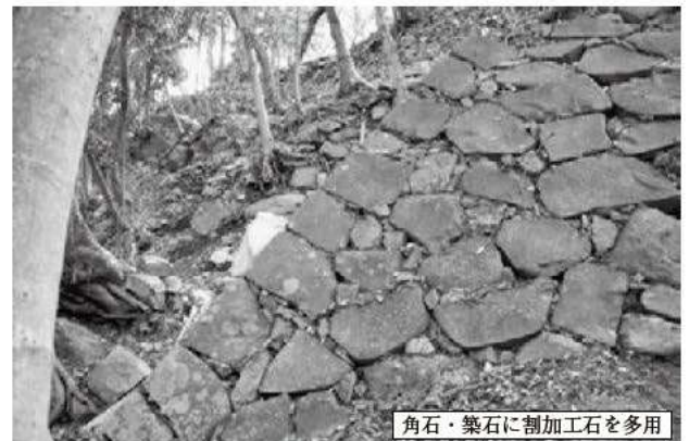
④ 名護屋城三ノ丸北西櫓台隅角部 角石・築石に割加工石を多用 控えが短く、算木 積みとされない
