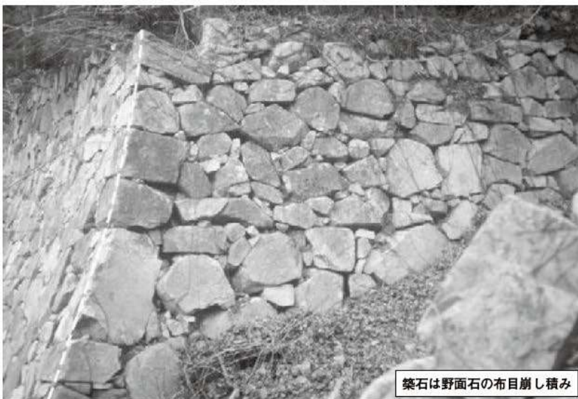
⑤ 山上部 隅角部 (角石の控えが短く、稜線に僅かに「反り」がみられる)
