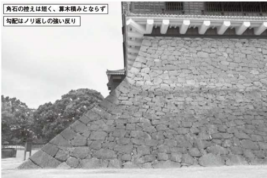
① 大天守台南西隅角部 (西より)
