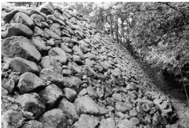
写真 20 武田氏館 天守台石垣東面 (非公開)
