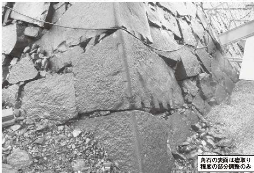
⑤ 小天守台北西隅角部拡大（角石稜線が丸く調整される）
