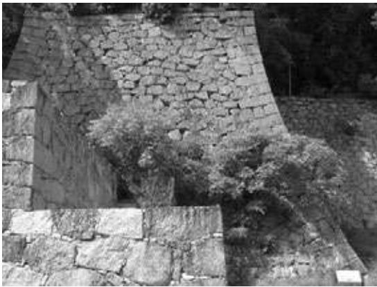
④ 松山城 3期 (西大砲台南東隅角部)
