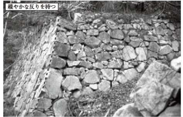
② 西生浦倭城 山上部隅角部 緩やかな反りを持つ 控えが短く、算木積み とされない隅角部。
