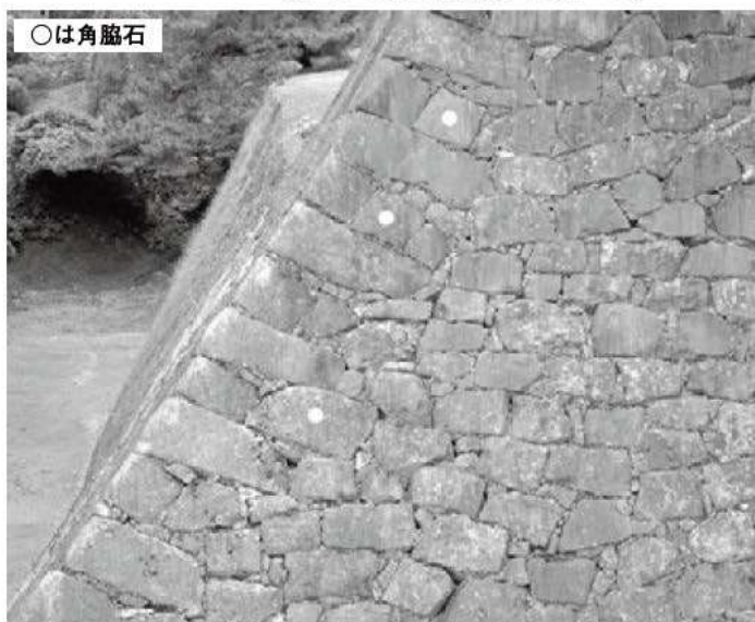
③ 宇土櫓下隅角部拡大 (西から) ※築石は高さが揃い、布目積みに近い
