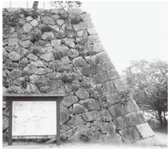
④ 天守台北東隅角部（東から）
