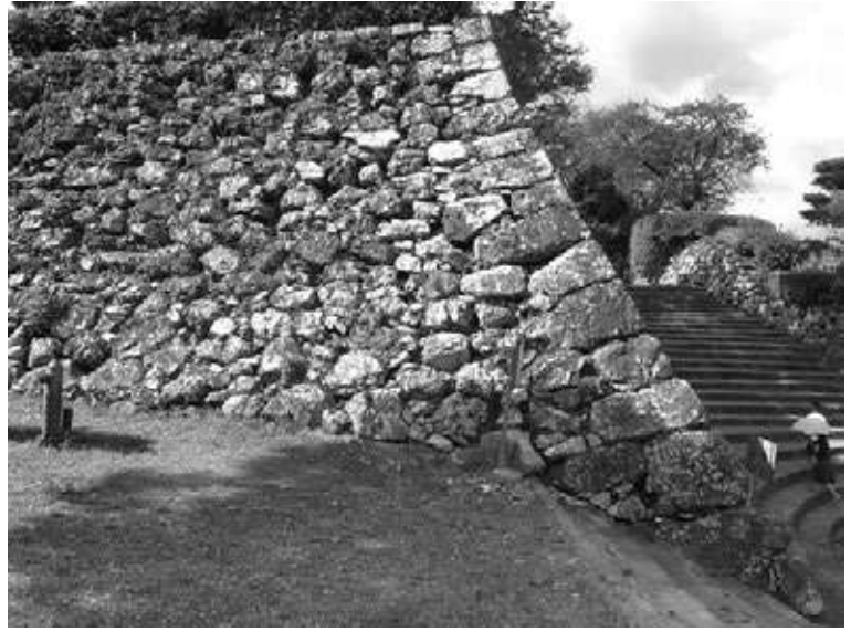
① 高知城 1 期（二ノ丸南東隅角部）
