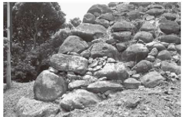
⑧ 名護屋城東出丸下北東隅角部 野面石による算木積み
