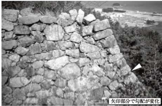
① 西生浦倭城 山上部隅角部 矢印部分で勾配が変化 控えが短く、算木積みと ならない隅角部
