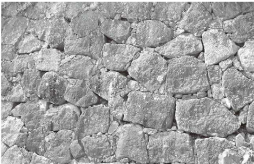
⑤ 天守台付櫓の築石（南から） ※築石表面は部分的なノミ調整を施す
