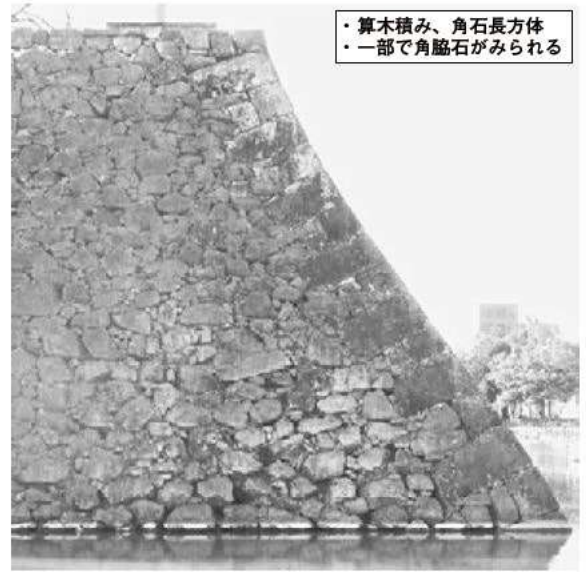
② 大天守台北西隅角部 (北から)
