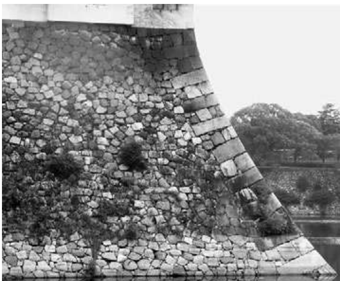
② 西外濠乾槽下隅角部 (小倉藩細川家) 左：北西面、右：北西より 隅角部の角石では高さ比べ控えの長い石材が目立つ
