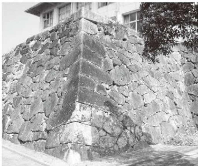
① 切手門石垣隅角部 (南東から)
