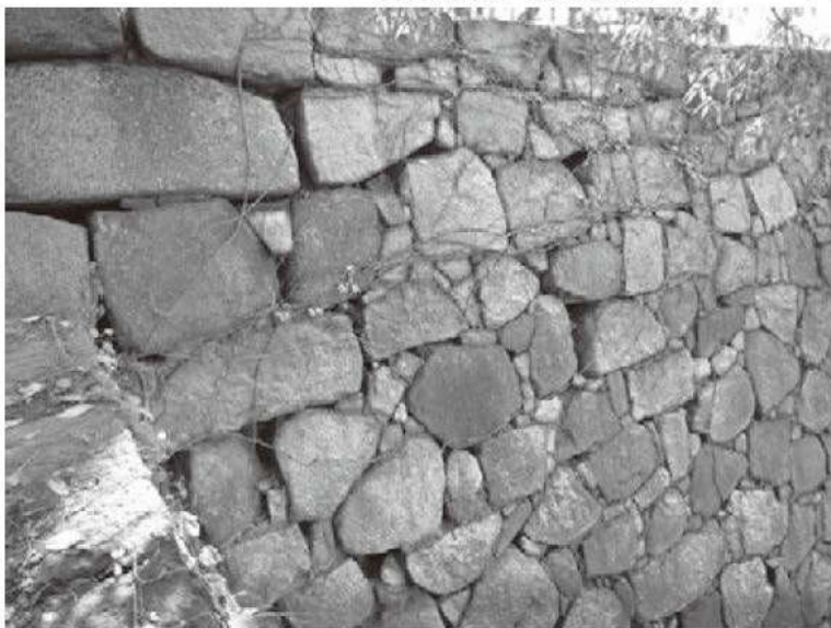
③ 大坂城 1 期加藤家丁場（西の丸西面築石部〔西外堀〕）
