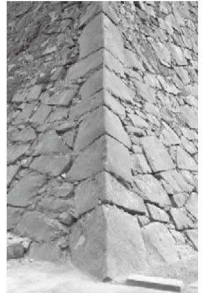
② 同隅角部稜線（南西から）
