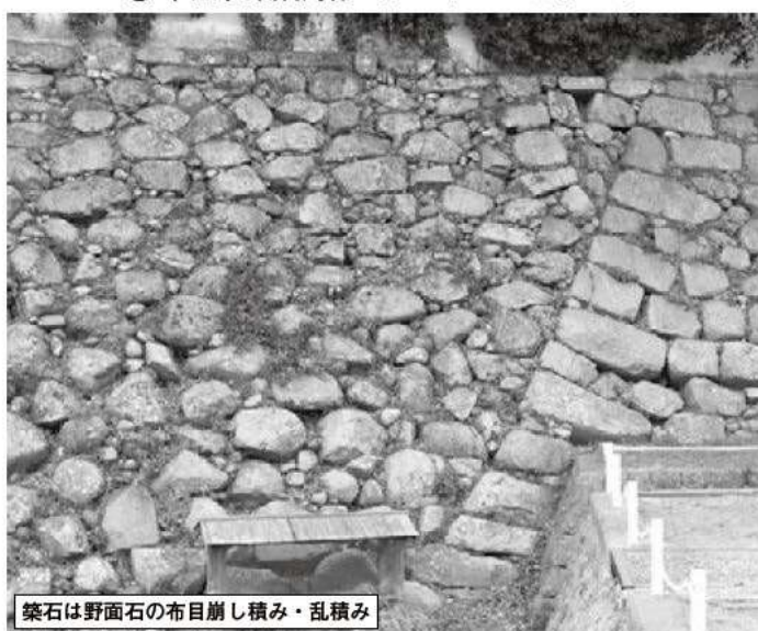
⑤ 本丸北面築石部 (黒田期石垣 [右] を埋めて細川期石垣を構築 [左])
