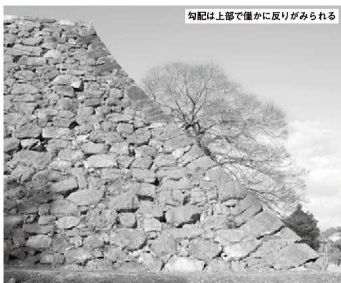
⑤ 小天守台南東隅角部 (南から)
