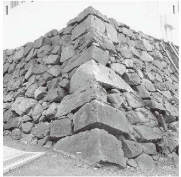
② 天守台南西隅角部（南西から）
