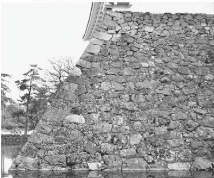
⑤ 天守台北東隅角部 (北から)
