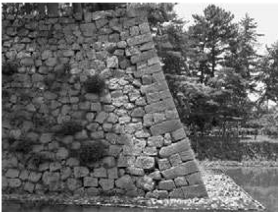
⑥ 津城藤堂家改修部分 (本丸北西隅角部)
