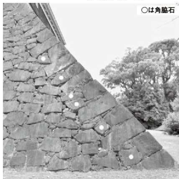
④ 東十八間櫓南東隅 (北西から)
