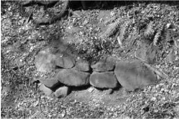
写真9 武田氏館 土壘法面の事例
