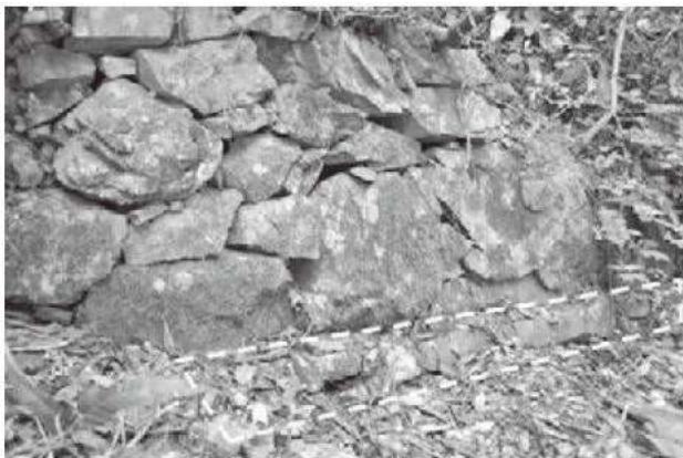
写真3 八王子城 根石部の構造1
