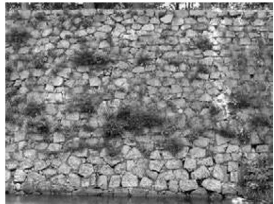
⑦ 津城藤堂家改修部分 (本丸北面築石部)
