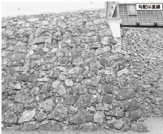
⑤ 本丸北西隅角部（北から）
