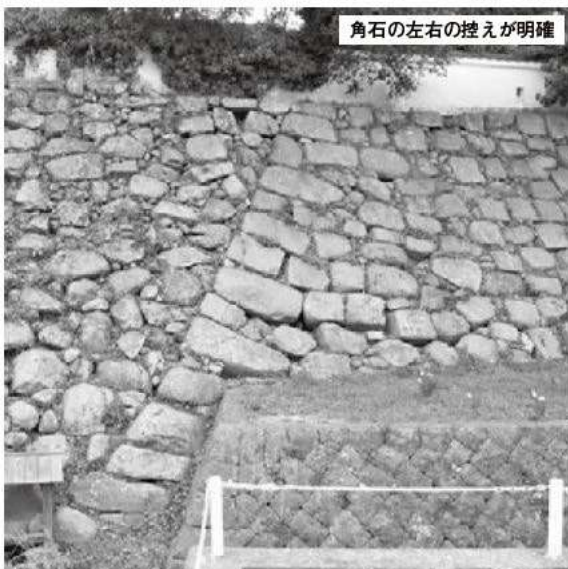
③ 本丸北面石垣 (北から、細川期石垣に埋め込まれる)
