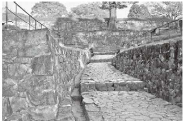
写真6 金山城 大手虎口 (復元整備後)
