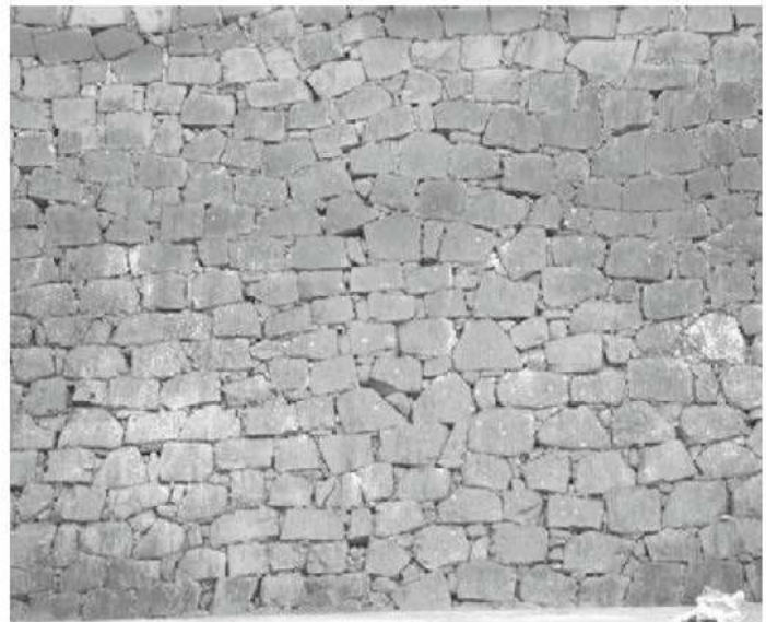
④ 同左、西面築石部（西から）※築石の高さが揃う布目積み
