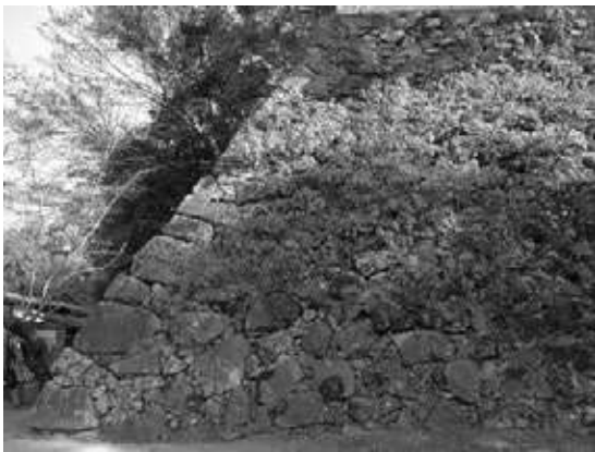
⑤ 宇和島城藤堂家改修部分（藤兵衛丸北西隅角部）
