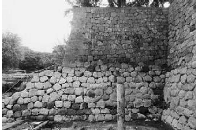
解体前の状況
