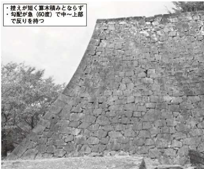
① 飯田丸隅櫓下隅角部 [A-2類] (東から)
