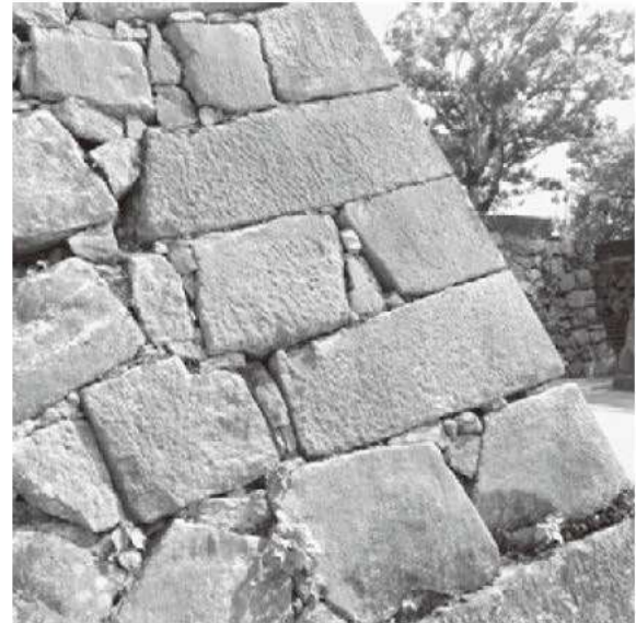
② 天守台北西隅角部
