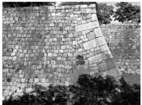
⑧ 大坂城 2 期生駒家丁場 (本丸南西隅角部 [ 内堀 ])
