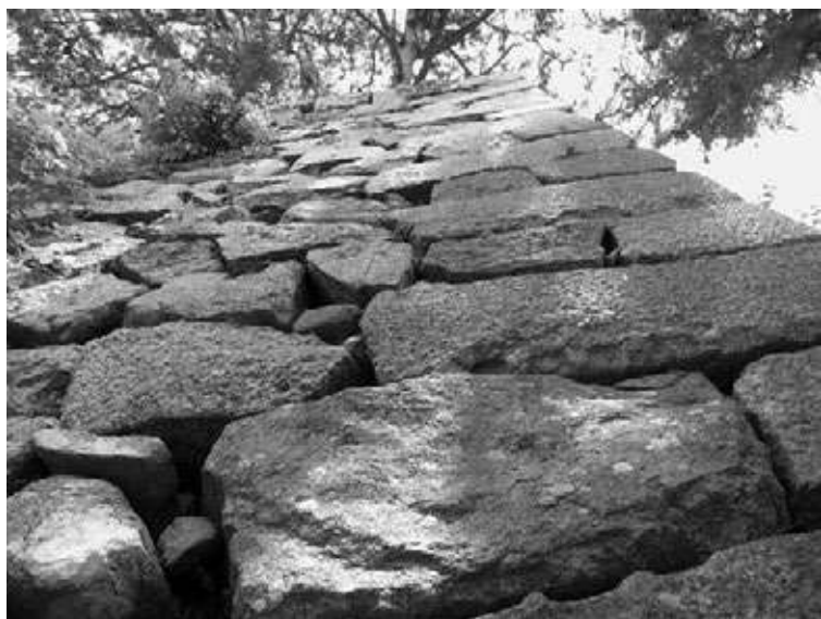
② 津城藤堂家改修部分（本丸北面隅角部）
