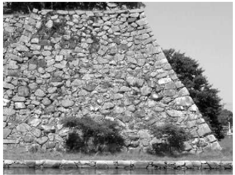
② 今治城（本丸南東隅角部）
