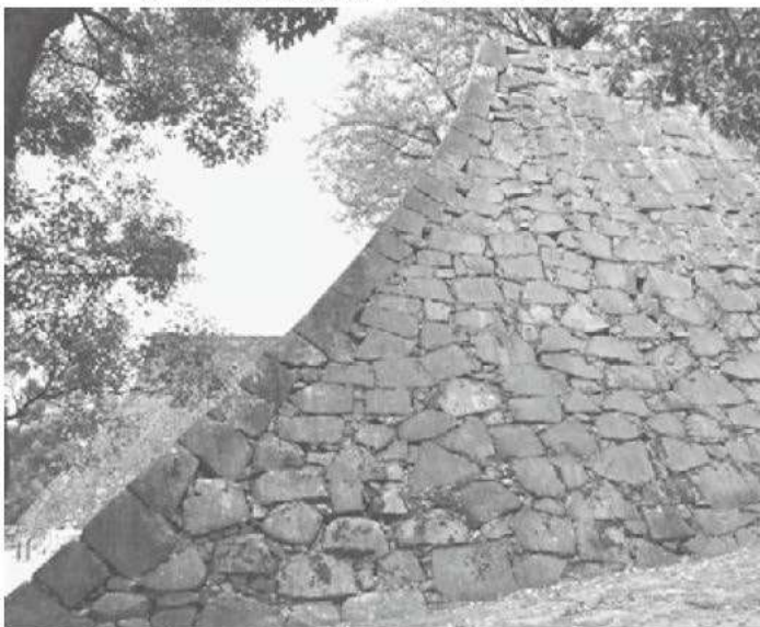
⑤ 本丸南東隅角部（東から）
