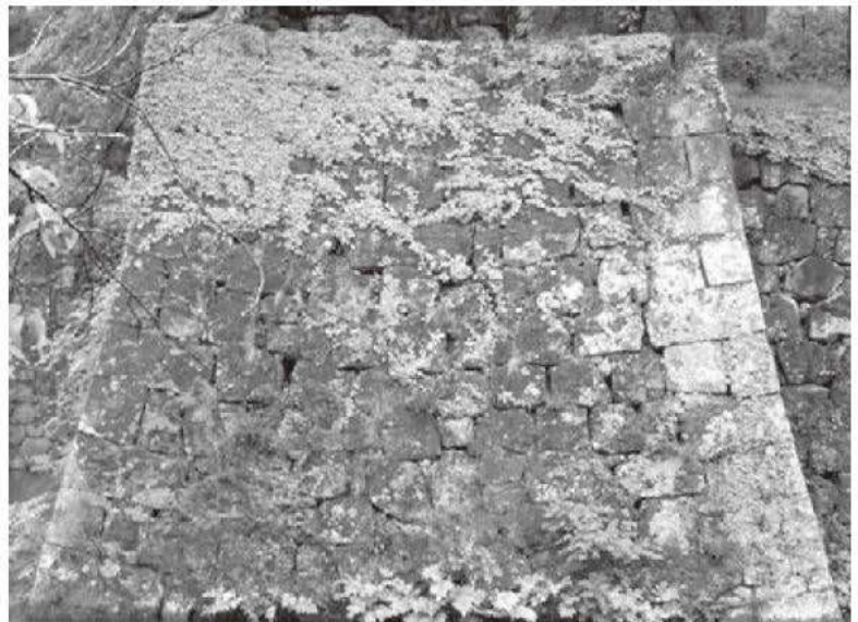
② 若松城加藤家改修部分（北出丸北東隅角部）
