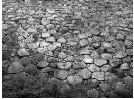
② 松山城 1 期（東郭東面築石部）
