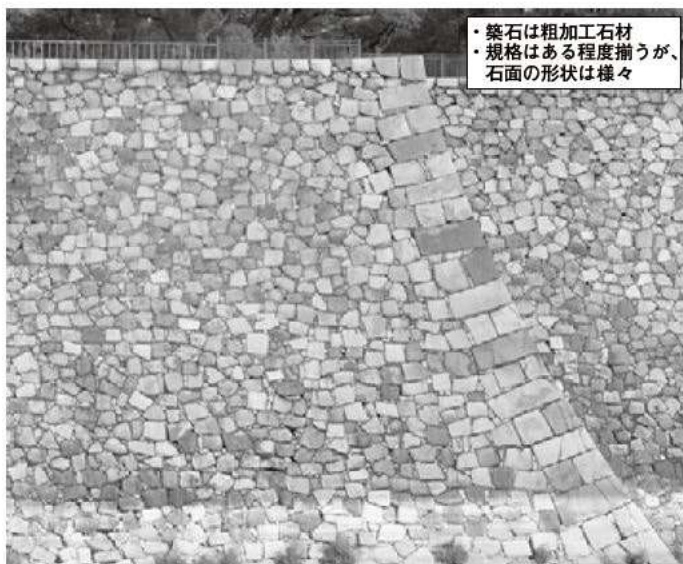
① 西外濠隅角部 (西から)
