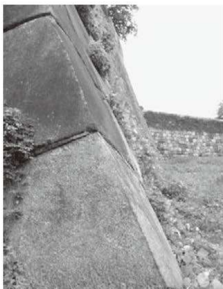
③ 大坂城 2 期藤堂家丁場（左：胴張りの様子、中：加工された間詰め石、右：間詰め石のための角石への加工）
