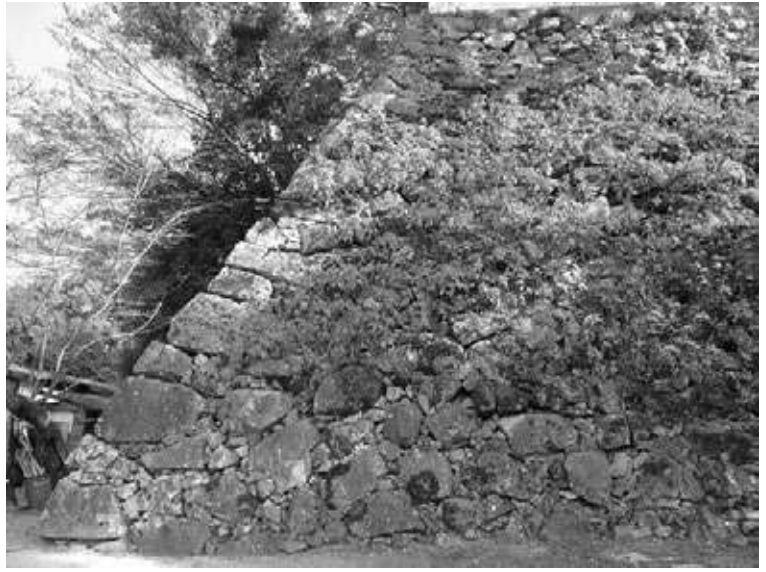
① 宇和島城藤堂家改修部分（藤兵衛丸北西隅角部）
