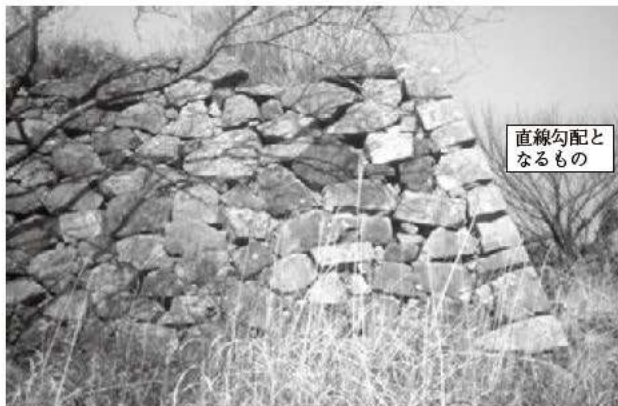
③ 西生浦倭城 山上部隅角部 直線勾配と なるもの 控えが短く、算木積みと ならない隅角部。
