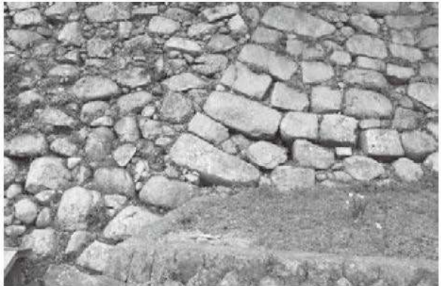
④ 中津城本丸北面 細川期石垣(左)に埋め込まれた黒田期石垣。神籠石石材の転用による控えの長い算木積み
