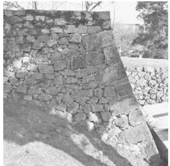
⑥ 大天守台南東隅角部 (南から)
