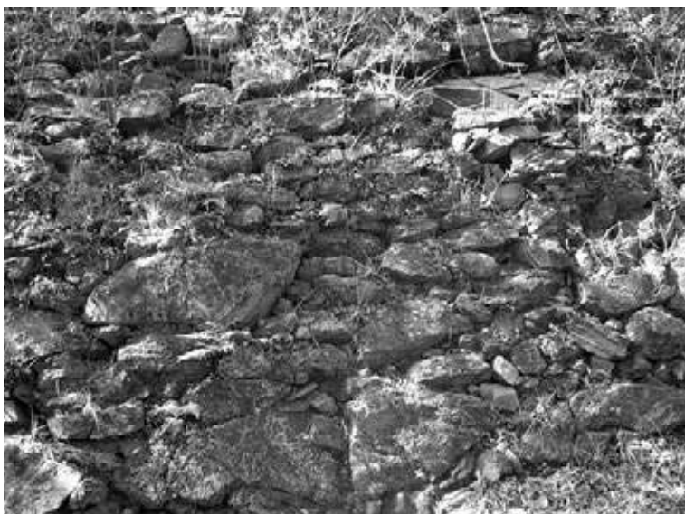
② 徳島城 1 期（本丸北面築石部）
