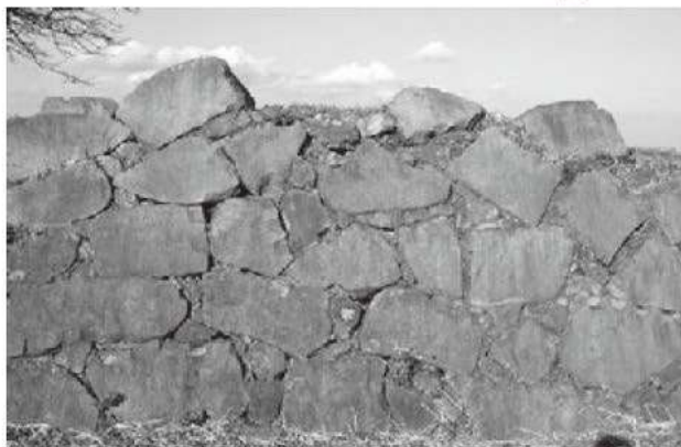
⑤ 名護屋城天守台東面割面石垣 割加工石を主体とする 平面性の高い築石
