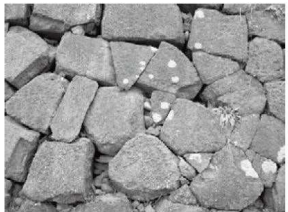
板状詰石の配置状況
