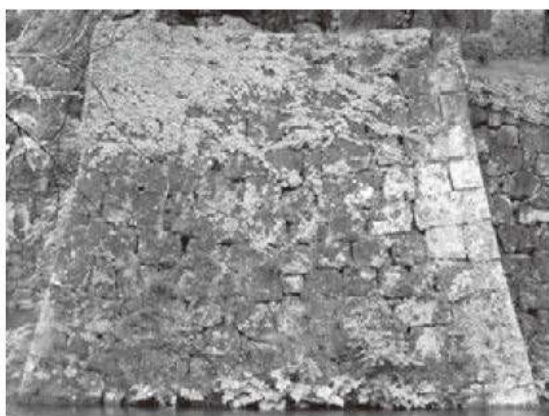
⑤ 若松城加藤家改修部分（北出丸北東隅角部）
