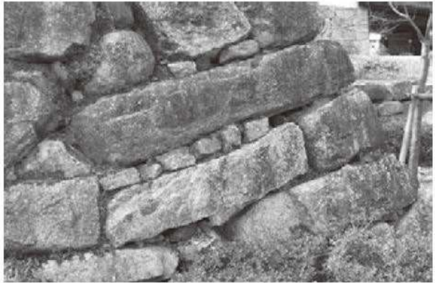
② 田辺城天守台隅角部 (拡大) 角石は横長の野面石を選択して使用
