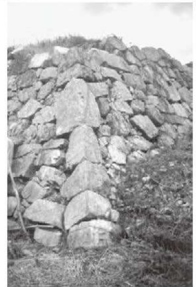
⑥ 縦石積みの隅角部
