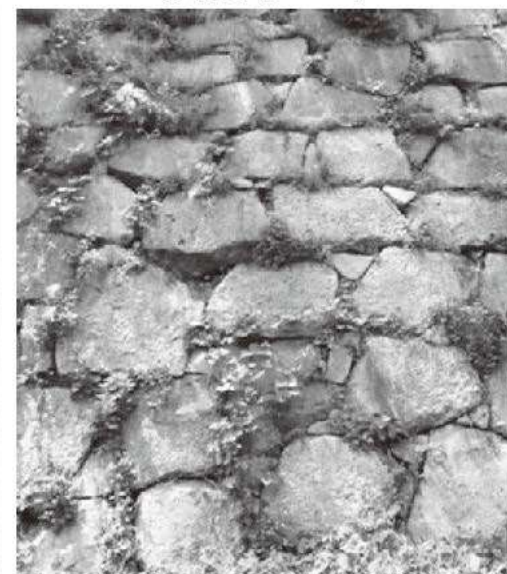
⑥ 同左、北面築石部 (北から)
