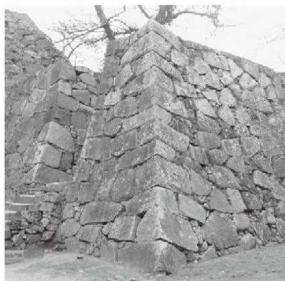
⑥ 天守台付櫓台（北東から）
