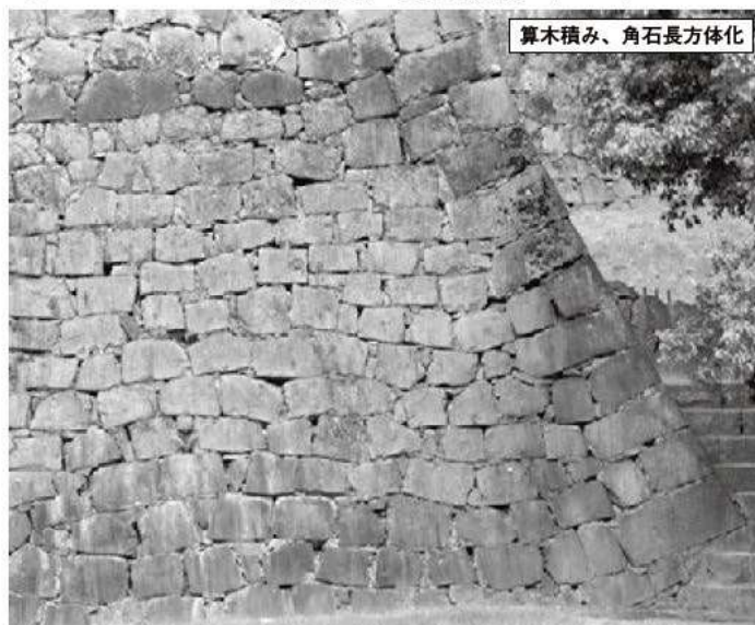
⑥ 同左、北東隅角部 (南東から) ※築石の高さが揃う布目積み
