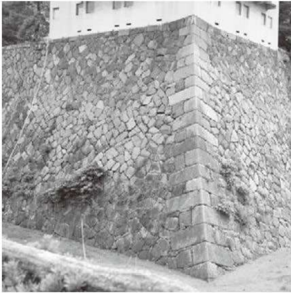
① 本丸西南隅櫓隅角部 (鍋島家丁場、南西より)
