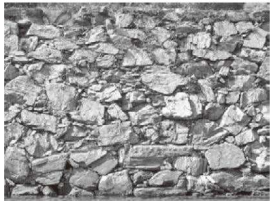
⑧ 徳島城 3期（山下部御殿跡東面築石部）
