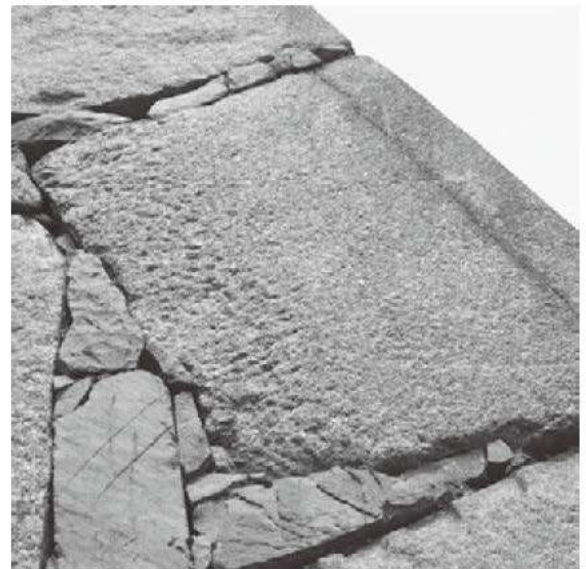
④ 同左、角石の表面は丁寧な敲彫による調整
