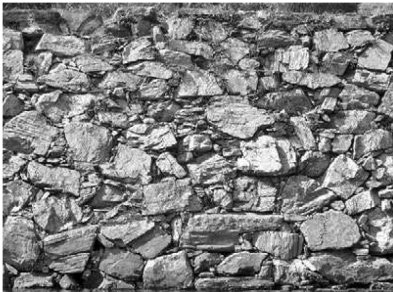
③ 徳島城 3期 (山下部御殿跡東面築石部)
