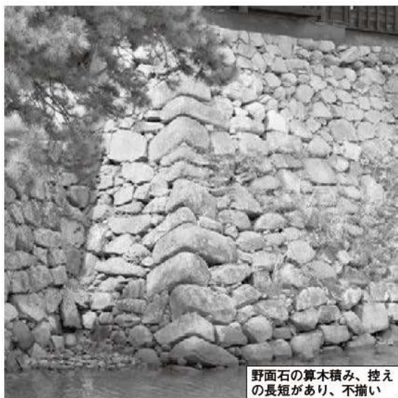
① 本丸東面石垣隅角部 (南東から)
