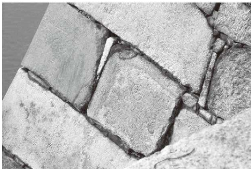
⑥ 同左、隅角部拡大 (⊕の刻印が小口面にみられる)
