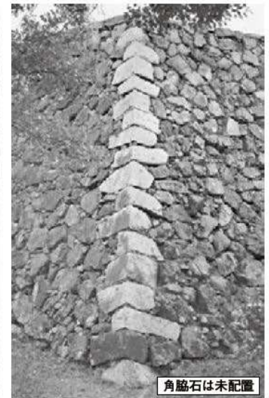
④ 同左（北東から）
