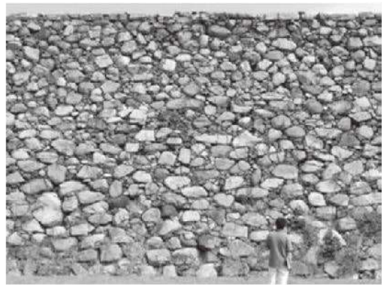
⑥ 高松城（本丸天守台南面築石部） ※解体前
