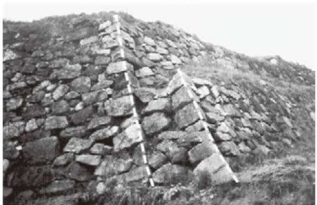
⑧ 機張倭城本丸隅角部 改修により旧石垣の前面を新石垣で抑えている。改修前の隅角部は算木積みを意識するが控えは短く不揃い
