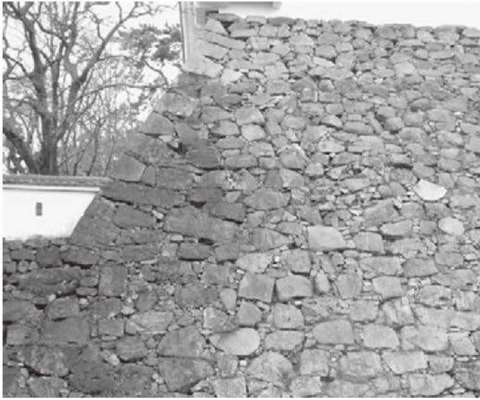
① 天守台南東隅角部（東から）
