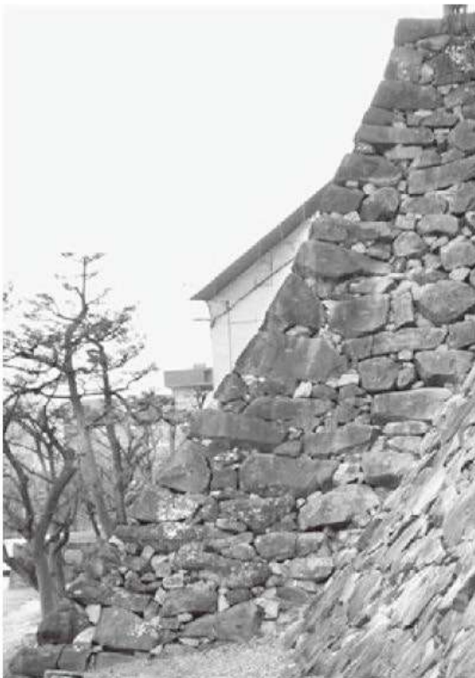
写真 28 甲府城 本丸南面石垣 (金沢型)
