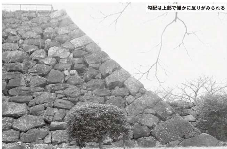
① 大天守台南東隅角部 (南から)
