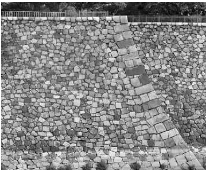
① 西外濠隅角部 (福岡藩黒田家) 左：西面、右：同拡大 隅角部と築石部が噛み合わない部分が多い (「隅角部の独立化」)
