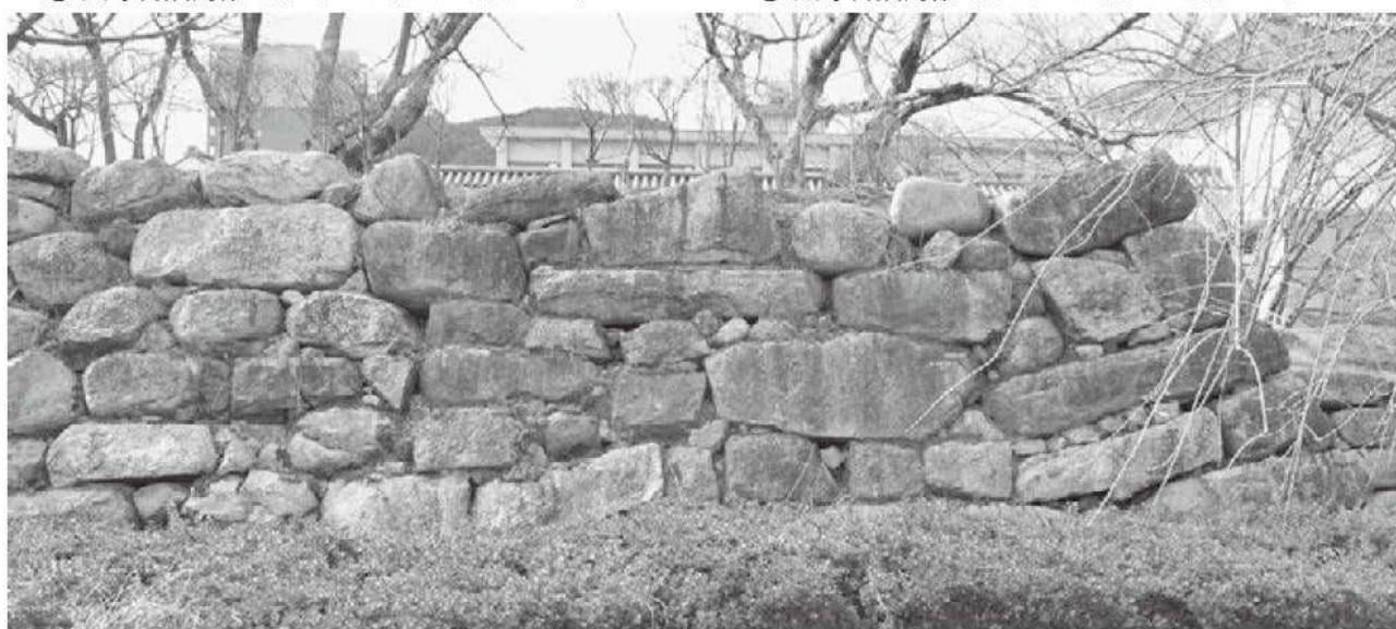
⑤ 天守台築石部（最上段は整備に伴う積み足し、一部旧材が残存。横長の石材を横位に配置し、横目地が通る部分が多い）
