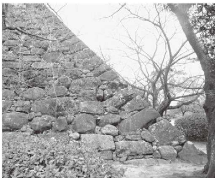
③ 大天守台北東隅角部 (東から)
