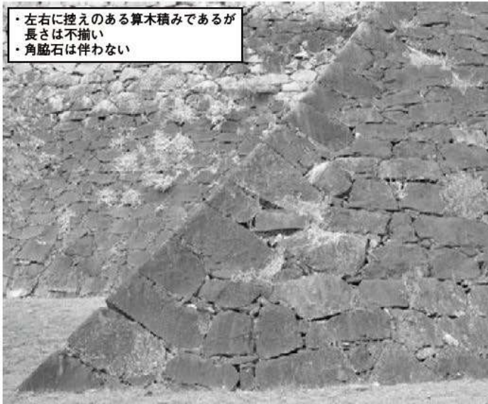
① 四間櫓下隅角部 (東から)
