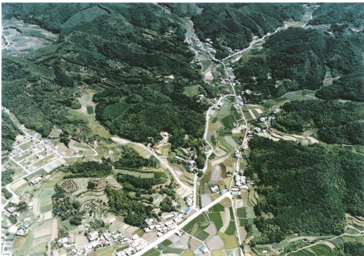
調査対象地 遠景 (S. 61 空撮)
