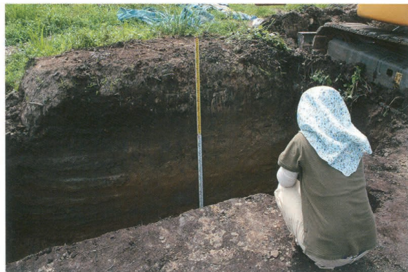
下層確認トレンチ
