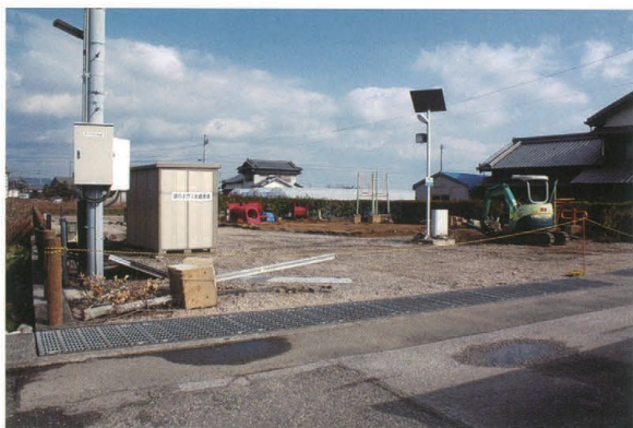
遊具等撤去作業中 (2014. 3. 5)
