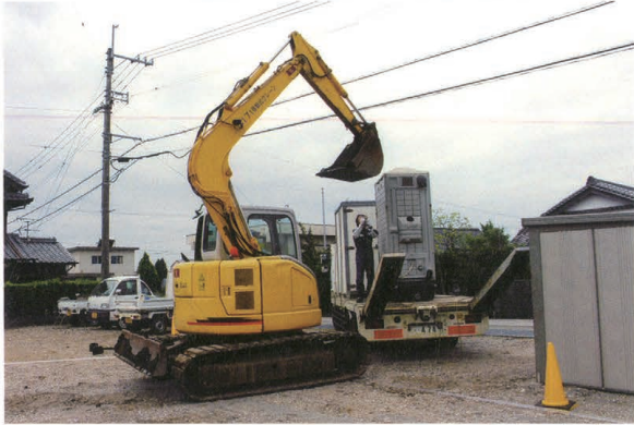
コンテナ・仮設トイレ搬入
