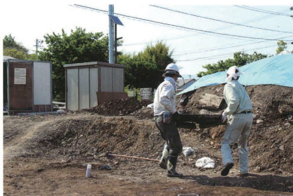
コンクリート片撤去
