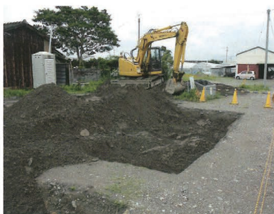
埋め戻し作業
