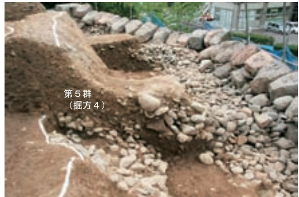
断面No.12 Dトレンチ 下層
