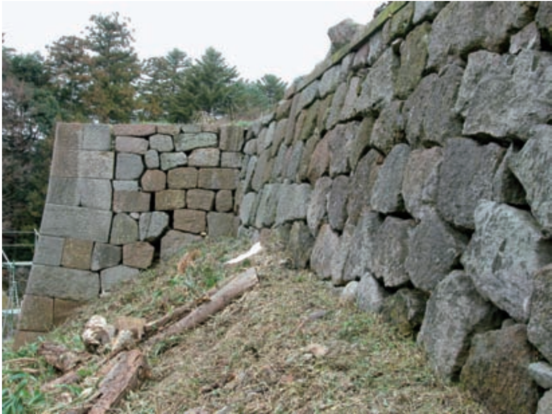
A・B面 調査着手前（平成15年）
