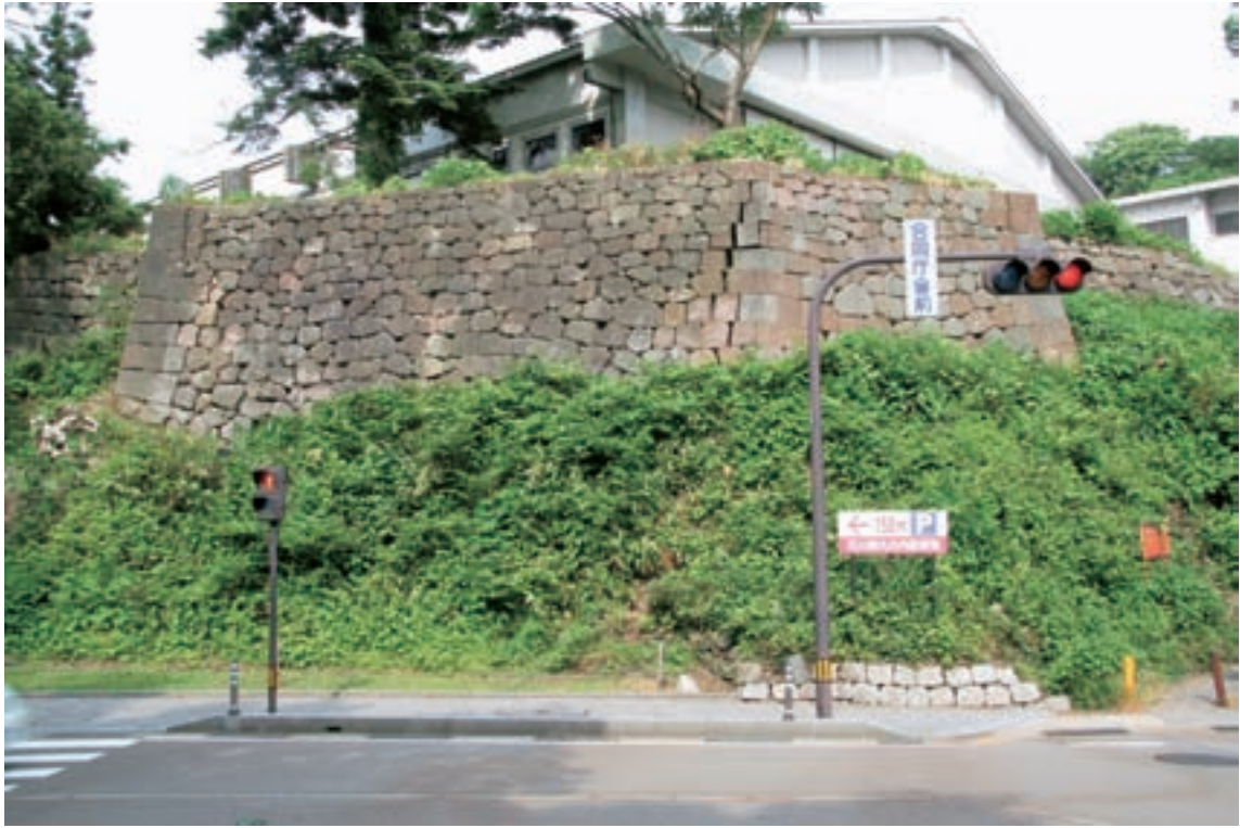
C・D面 調査着手前（平成16年）
