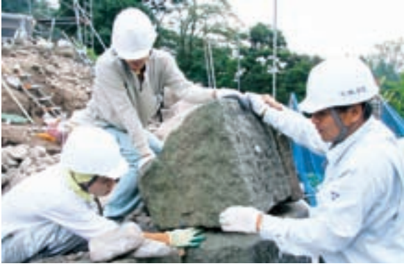
石材取り外し
