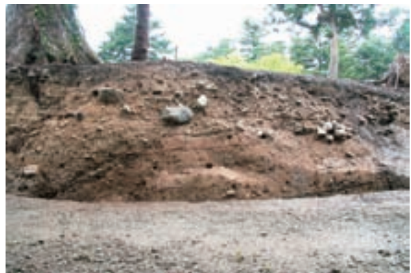
断面No.22 東側法面 2
