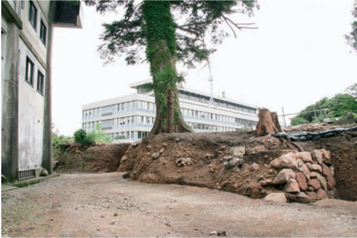
東側法面 全景
