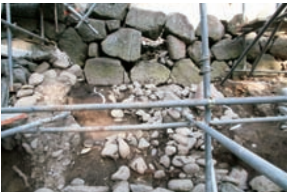
D面スツ 栗石詰め遺構
