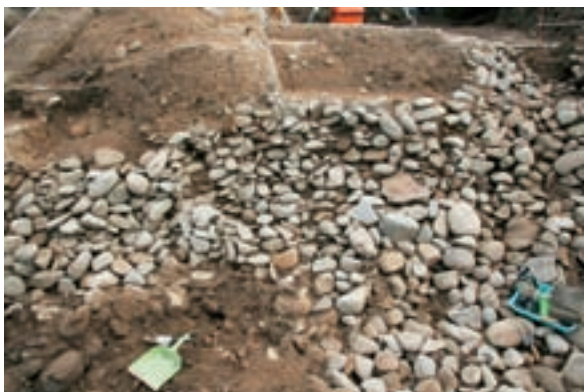
Dトレンチ背面ぐり石層 北側
